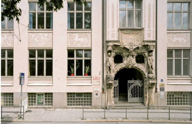
Grundschule in der Haimhauserstraße, München (1898)
