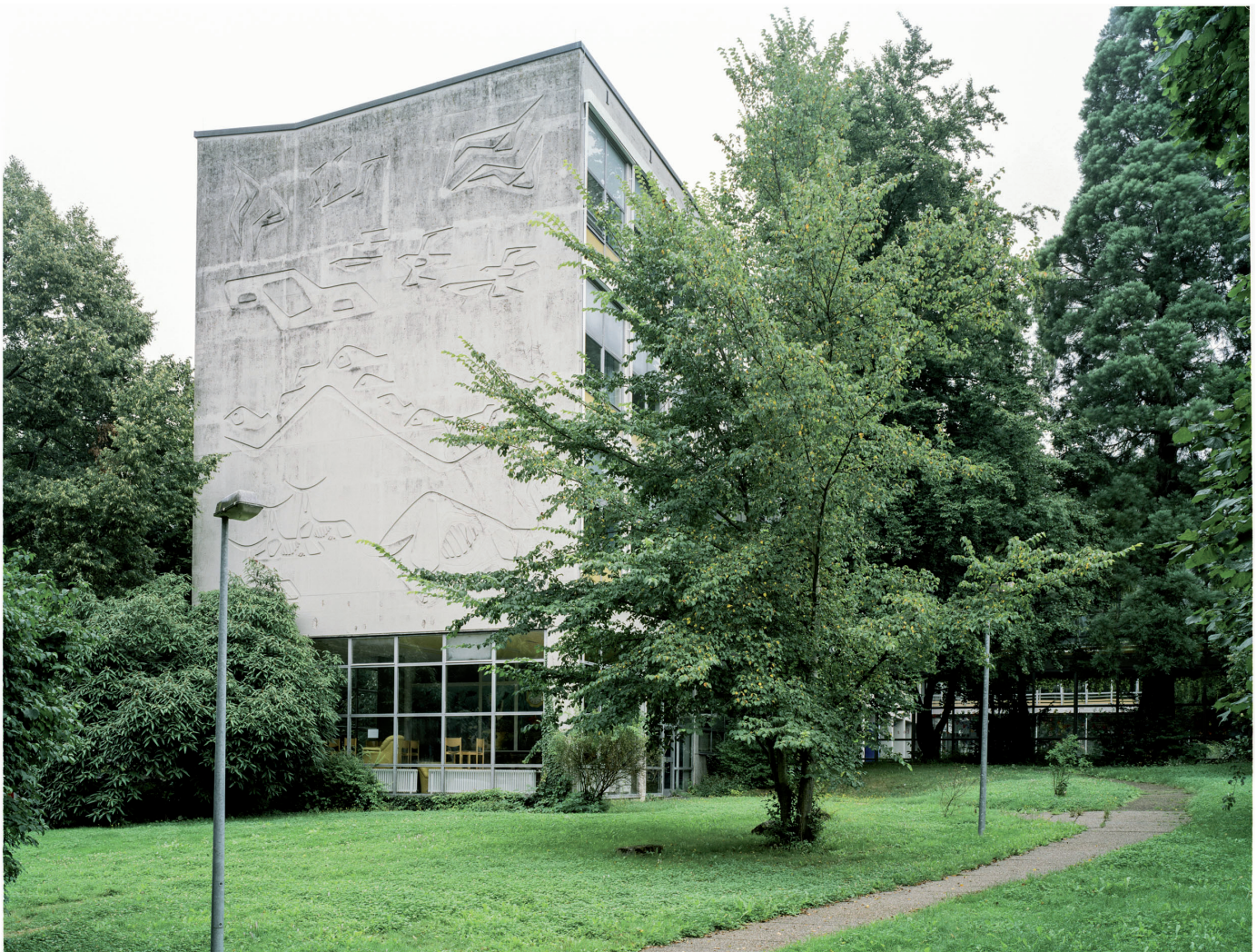
Abb. 2: Blick auf den 4-geschossigen Riegel mit seitlichem Fresko
