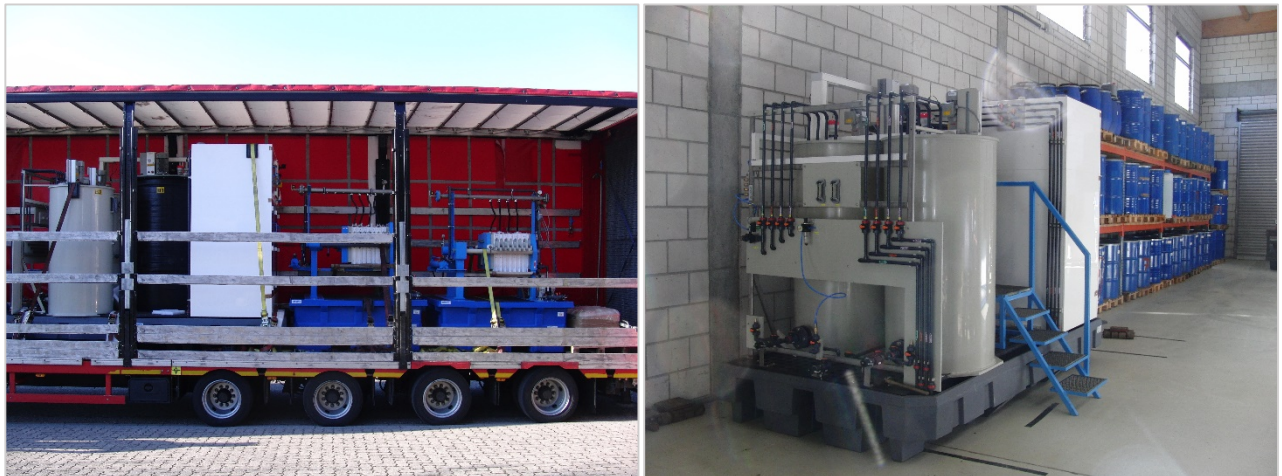
Abbildung 7: Hauptmodule und Filtermodule bei Anlieferung und positioniertes Hauptmodul
