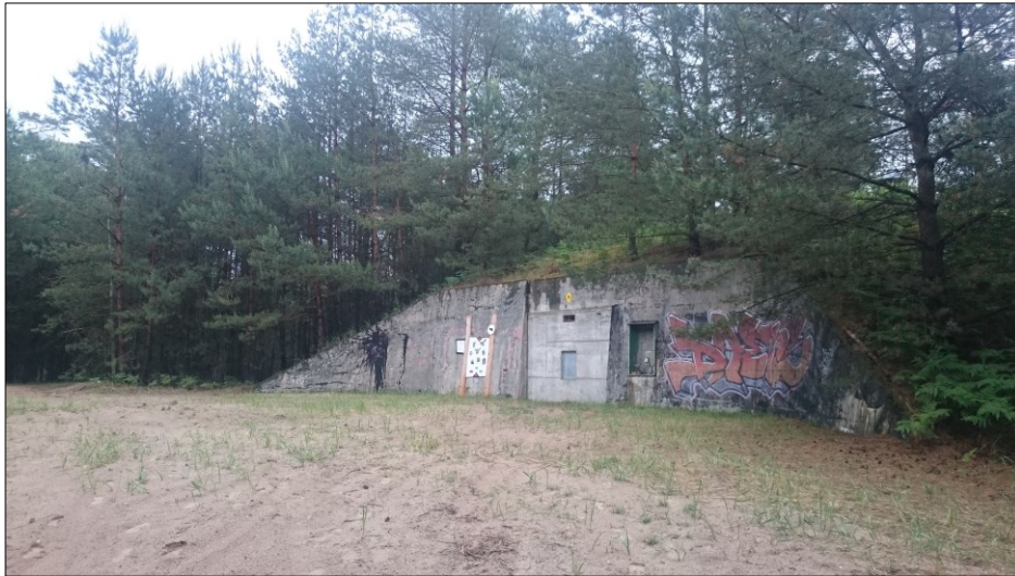
Abb. 1: Ehemaliger Militärbunker, der für als Fledermausquartier optimiert und gesichert wurde
