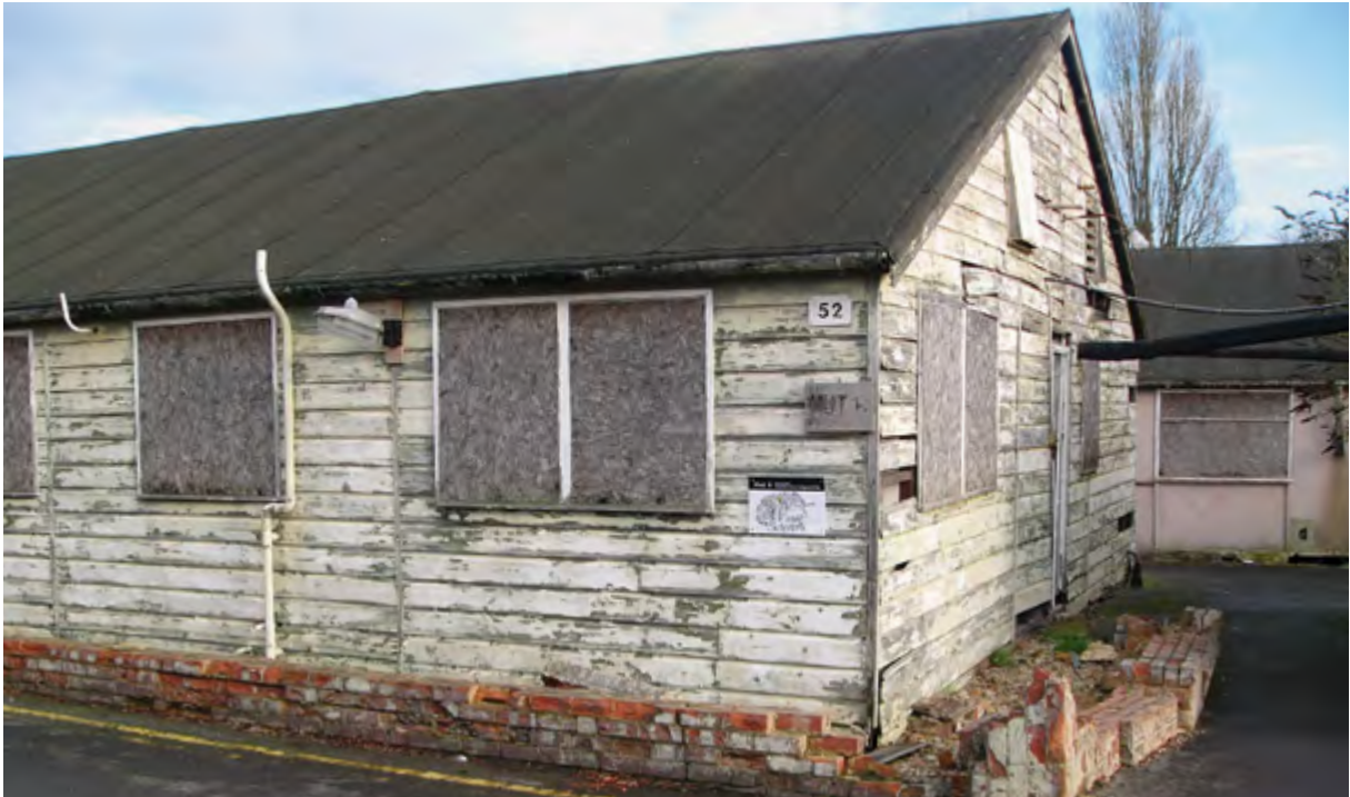
Abb. 3 / Baracken im Codebrecher-Zentrum von Bletchley Park, 2011
