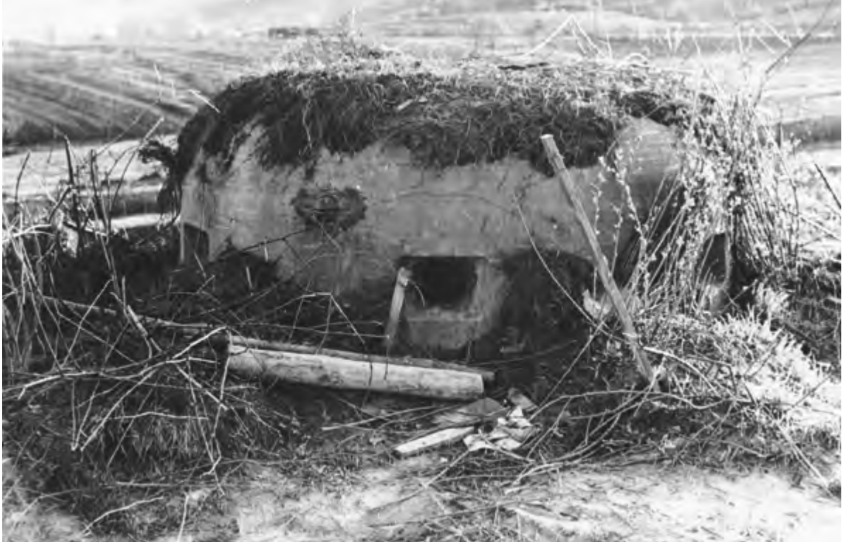
„Bei Bergzabern. 20.4.1940 Kaserne unter der Erde. Dieser getarnte Panzerturm ist im Gelände kaum zu erkennen, ganz unsichtbar aber ist das große Verteidigungswerk unter der Erde. Pop-Kp. 612 Bildberichter: Erich Bauer "
