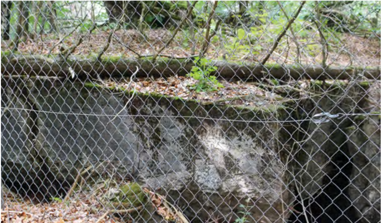
Gesicherte Bunkeranlage am ehemaligen Westwall
