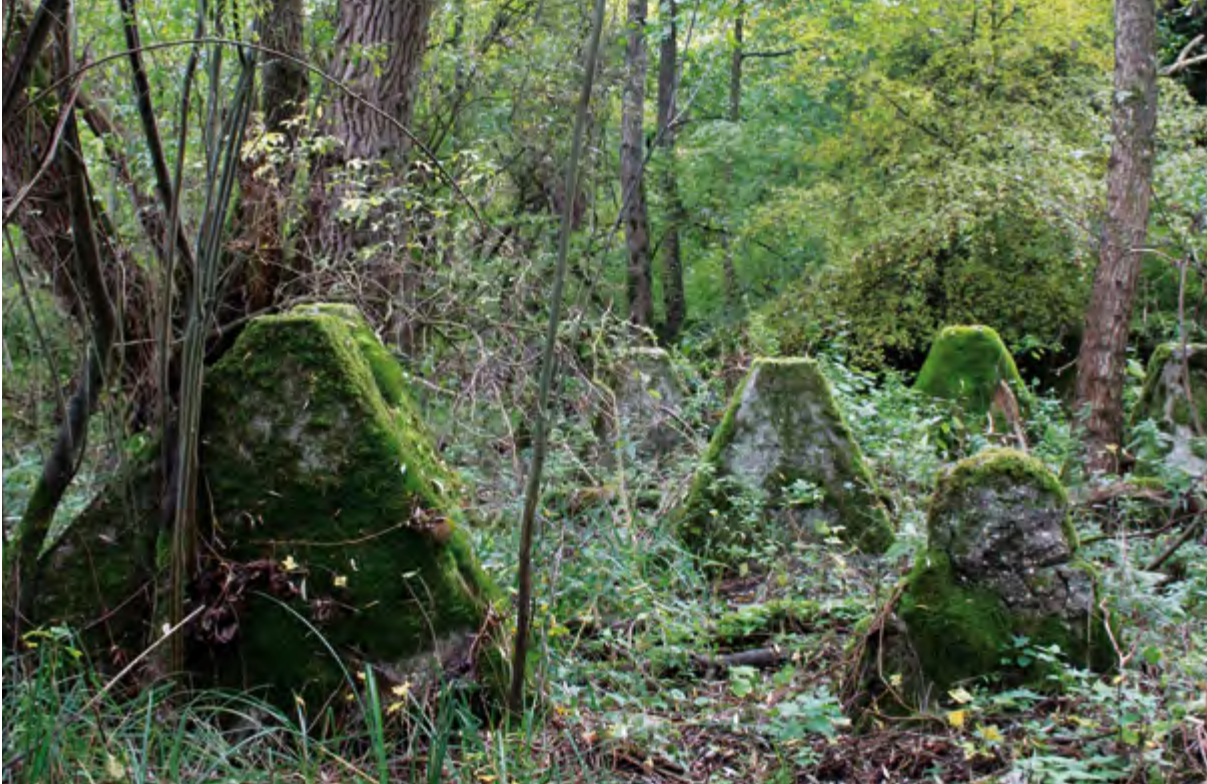
Höckerhindernis bei Niederrotterbach
