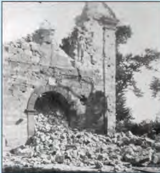
Lange Jahre mahnte der zerschossene Turm der Pfarrkirche an die verheerenden Auswirkungen von Westwallbau und Krieg für die Menschen des Grenzgebietes.
