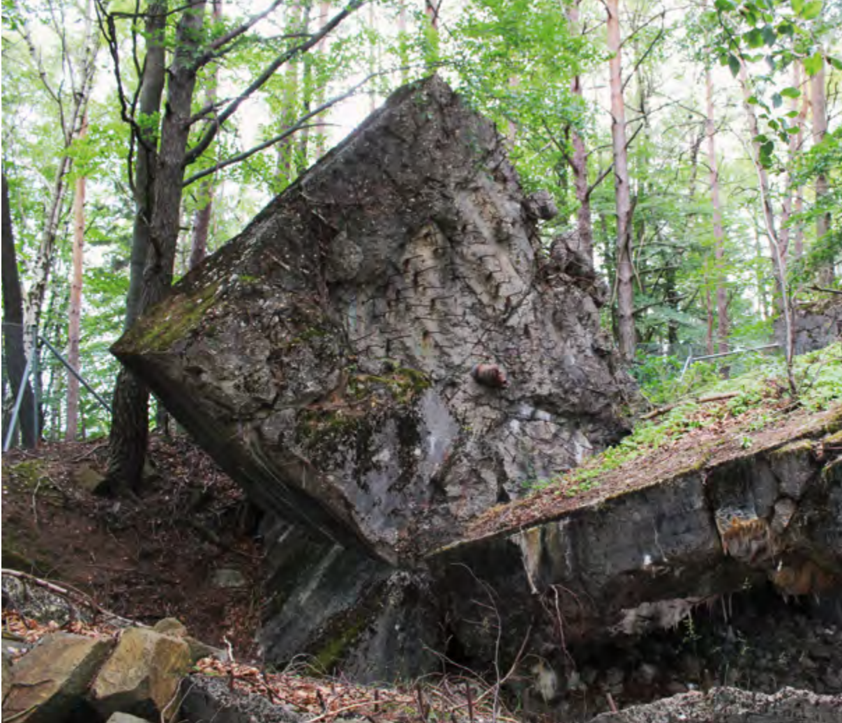
Verkehrssicherheit am WestWallWeg: Umzäunter gesprengter Bunker bei Oberrotterbach
