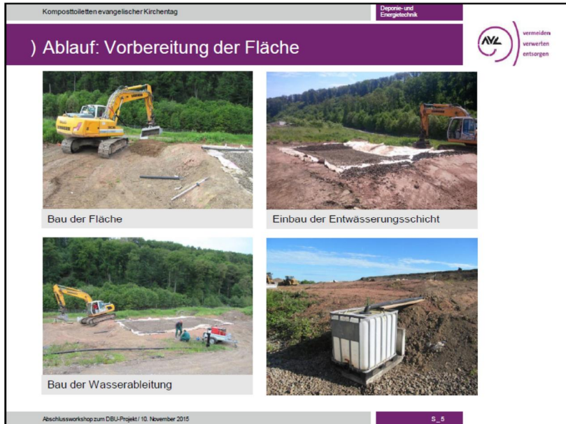
Abbildung 10: Ablauf: Vorbereitung der Fläche. Einbau der Entwässerungsschicht, Wasserableitung.
