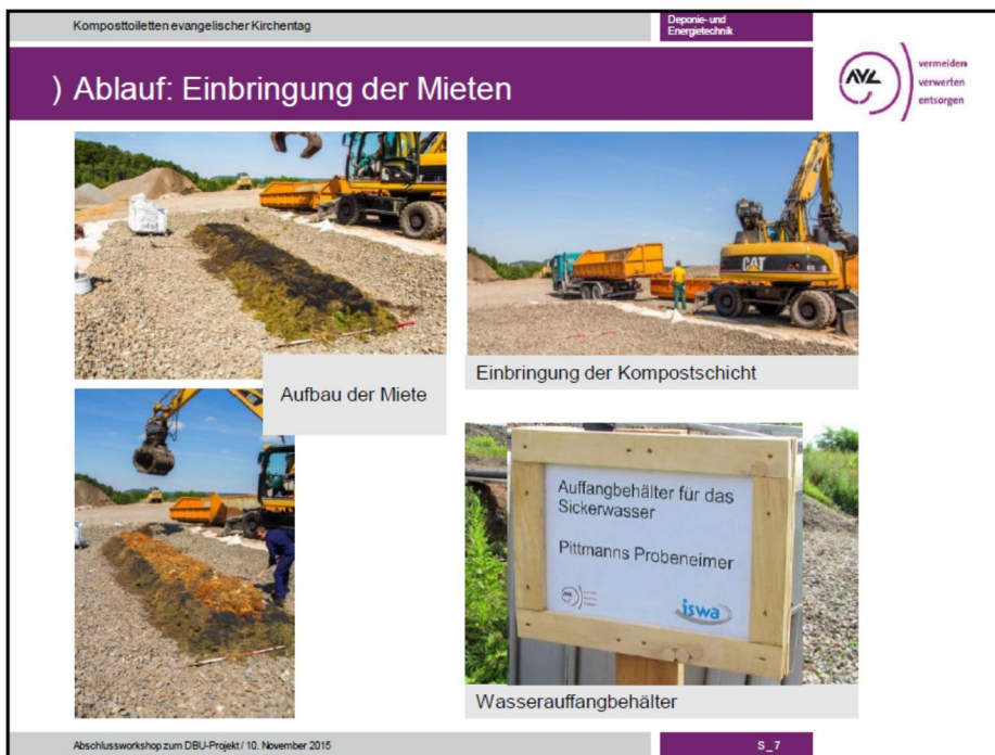
Abbildung 13: Ablauf: Einbringung des Materials, Aufbau der Miete, Sickerwasserbehälter
