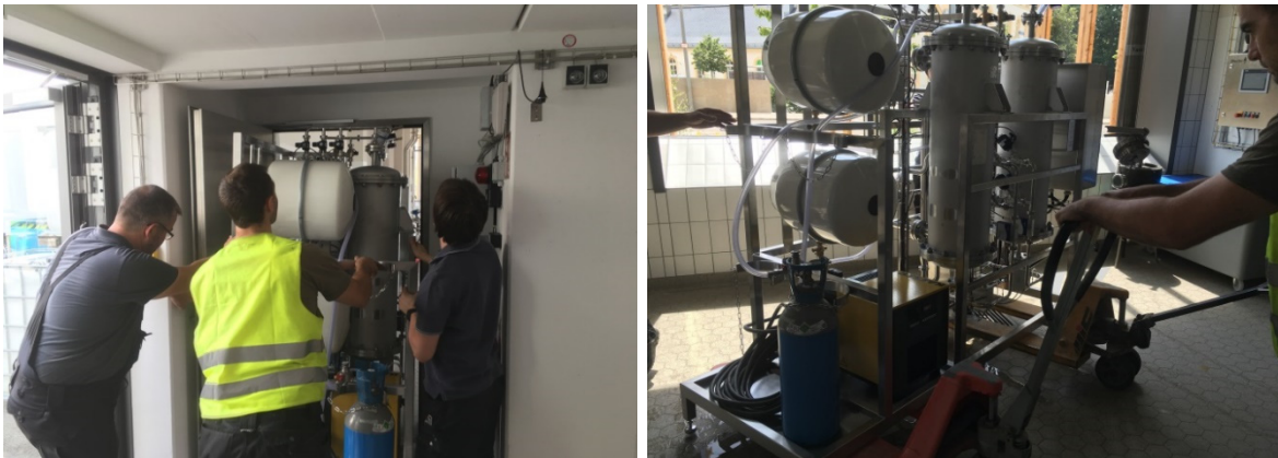
Abbildung 26: Einbringung der Pilotanlage.
