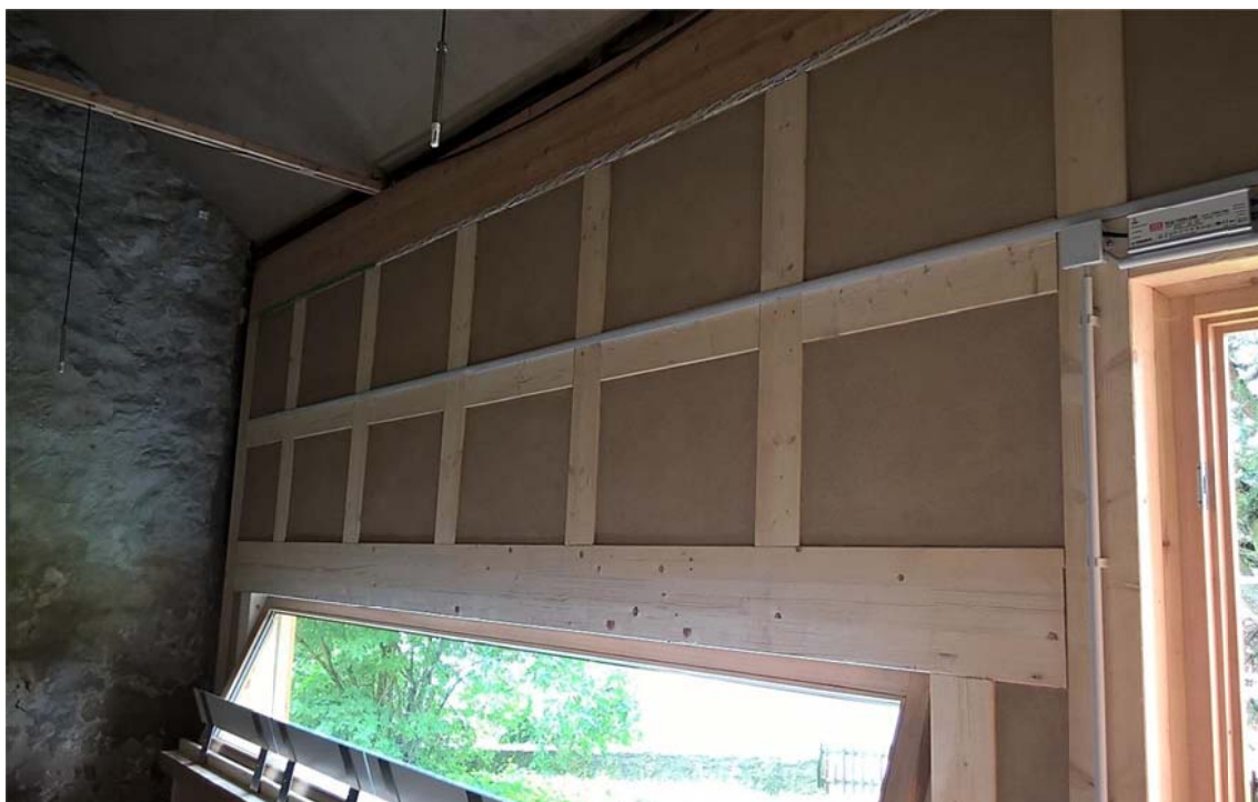
Abb. 10 Mit Lehmputz geschlossene Gefachflächen im Innenraum
