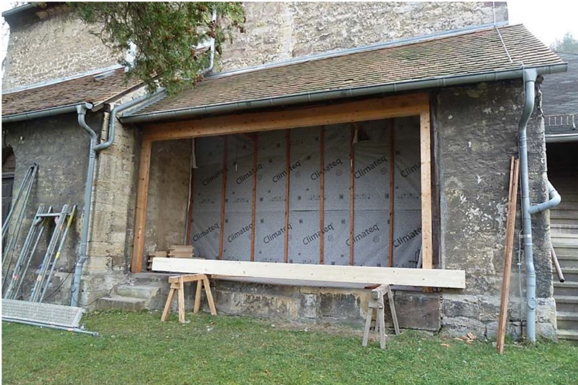
Abb. 7 Sicherung der Wandmalerei durch eine temporäre Schutzwand
