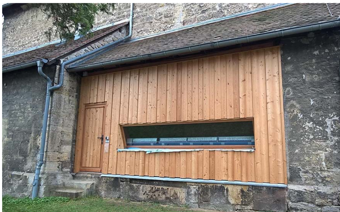
Abb. 14 fertige Schutzwand mit Fensterband und erkennbaren Erläuterungstafeln im Innenraum
