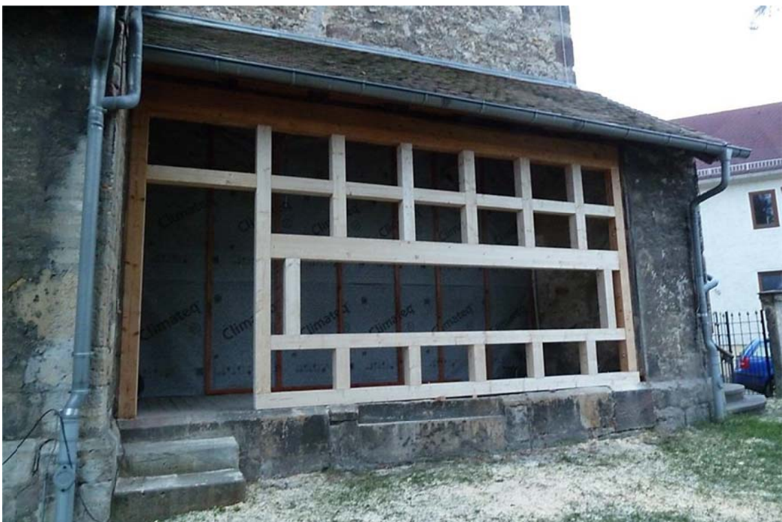
Abb. 8 Errichtung einer Fachwerkwand zur Aufnahme der notwendigen Tür- und Fensterkonstruktionen
