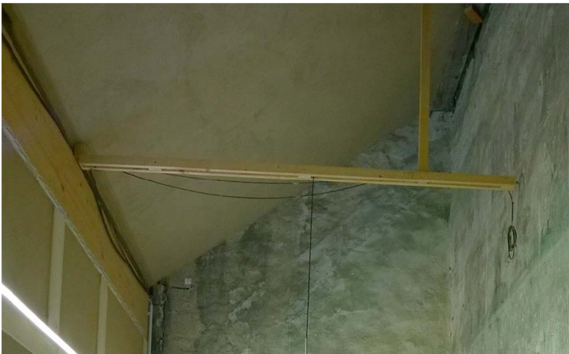
Abb. 12 mit einem Lehmputz geschlossene Dachunterseite
