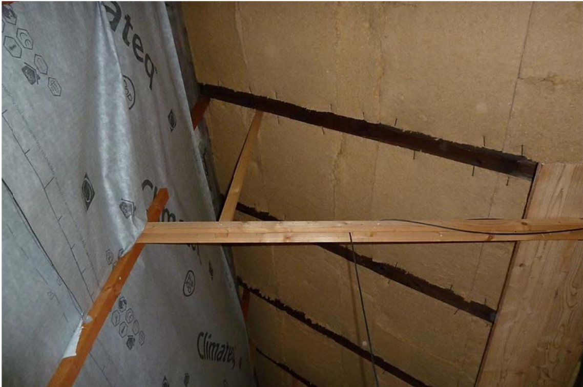
Abb. 11 mit Holzfaserdämmung gedämmter Dachbereich
