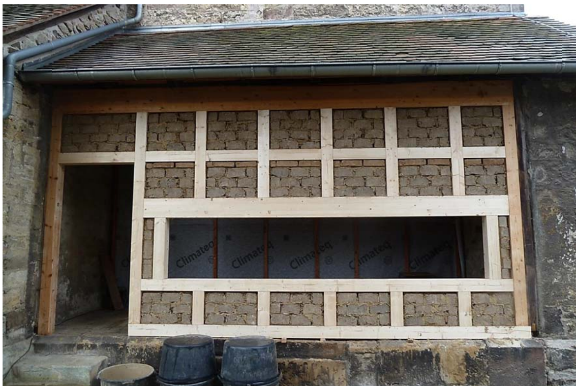
Abb. 9 Ausmauerung der Gefache mit Lehmsteinen
