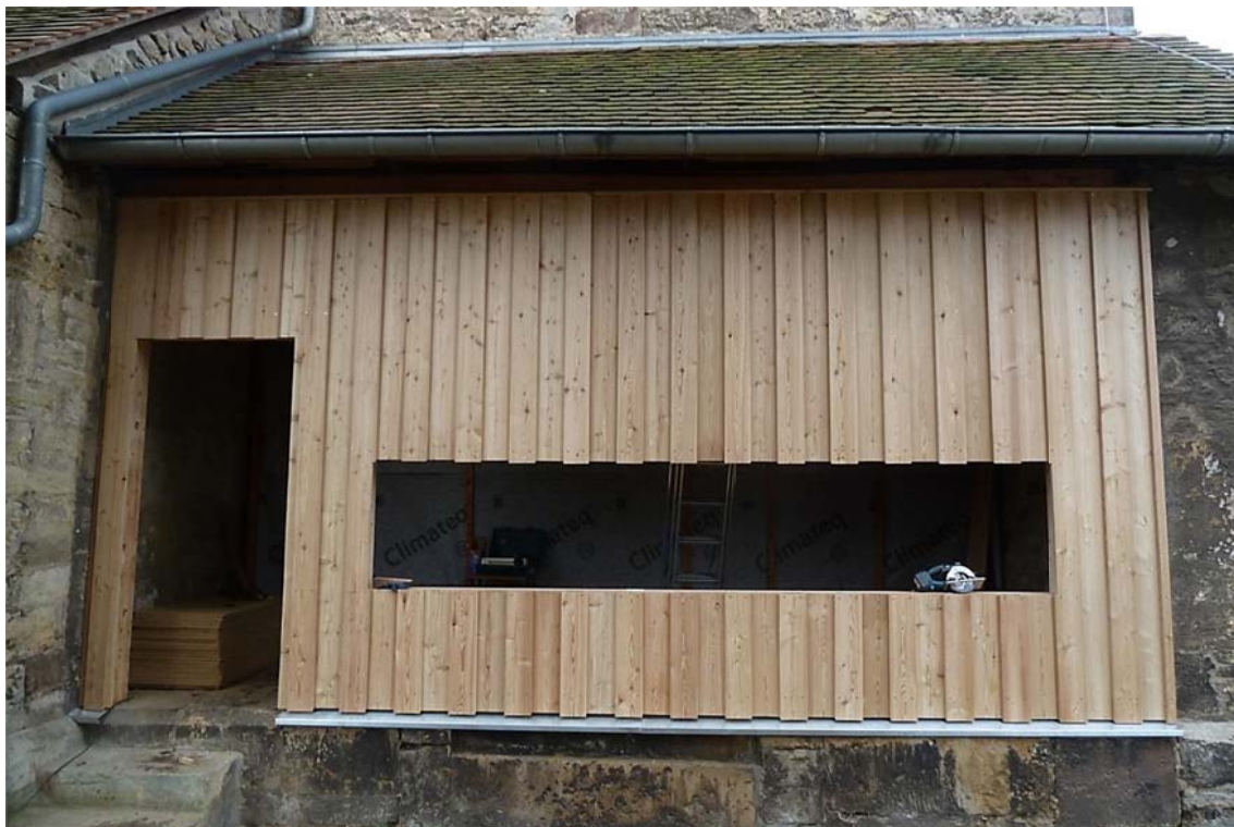
Abb. 13 Holzverkleidung der Außenfassade
