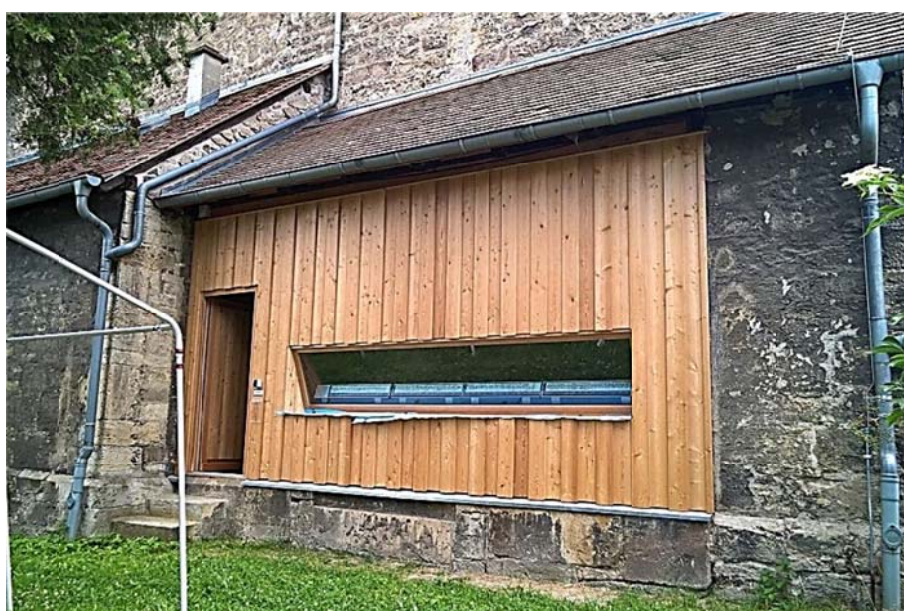
Abb. 18 Kirche St. Nicolai in Jena-Lichtenhain, überdachte Wandmalerei im fertig eingehausten Zustand Zeitraum: ab 2015
