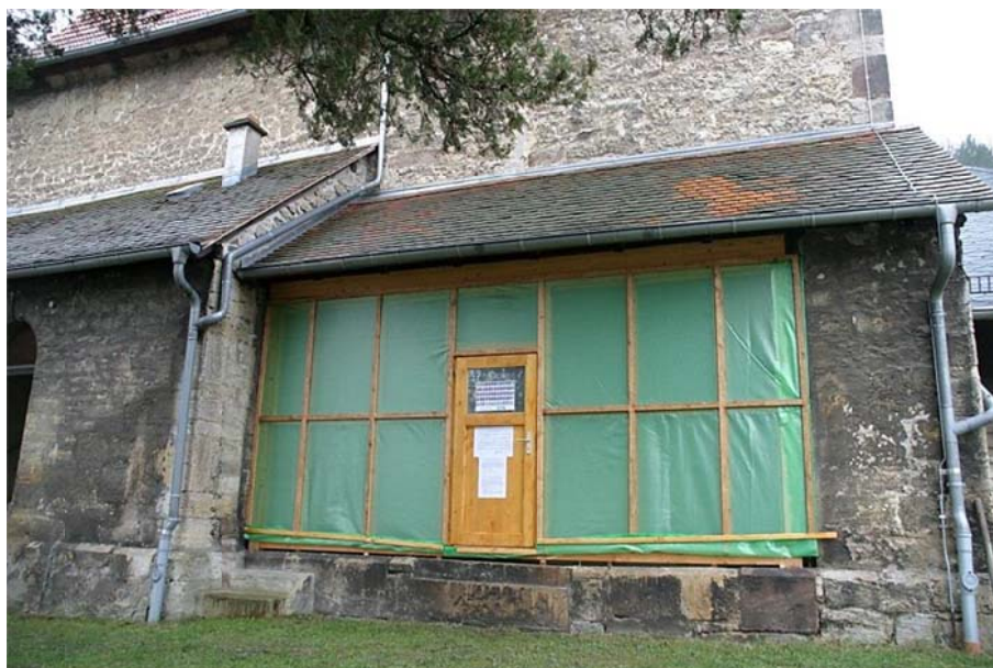
Abb. 17 Kirche St. Nicolai in Jena-Lichtenhain, überdachte Wandmalerei im temporär eingehausten Zustand Zeitraum: 2008 - 2015
