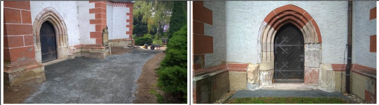
Abb. 26 Geländeregulierung im Bereich der Süd- und Nordfassade
