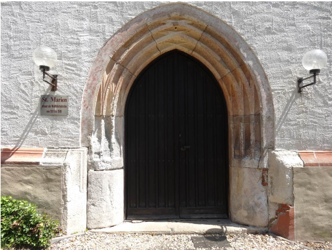
Abb. 7 Musterportal nach Abnahme von Fassung und Zementglätte
