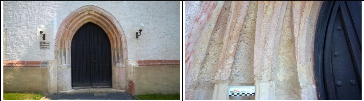
Abb. 30 Westportal nach Antragung der Steingänzungsmörtel (links). Rechts: Antragung an Vierung mit Zeitzer Sandstein im Übergang zum Ignimbrit (Detailaufnahme)
