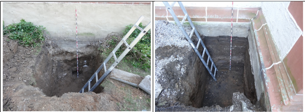
Abb. 15 Anlage von Schürfen für Feuchteuntersuchungen im Fundamentbereich
