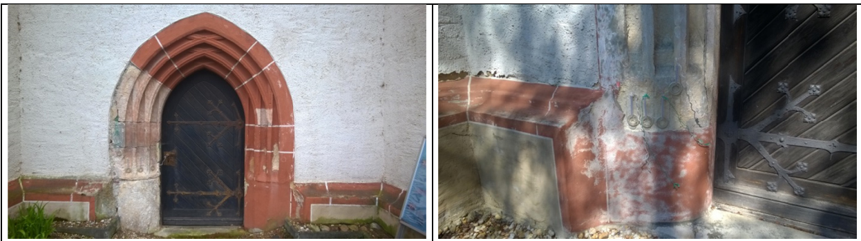
Abb. 18 Untersuchungen zur Wasseraufnahme nach Karsten an Musterflächen mit verschiedenen Steinfestigern
