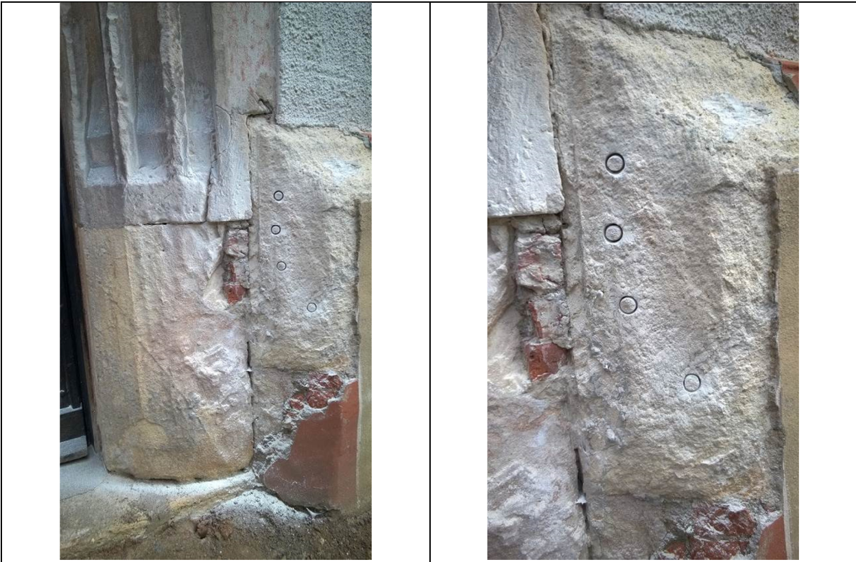
Abb. 23 Entnahme kleiner Bohrkerne an Musterflächen mit verschiedenen Steinfestigern zur Untersuchung
