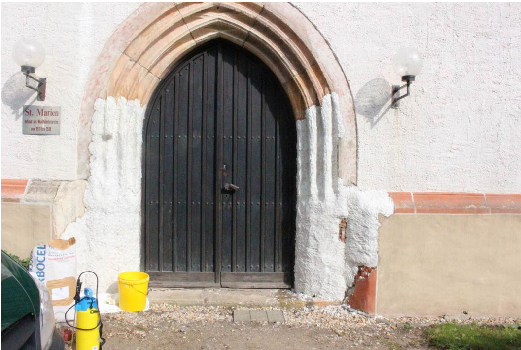
Abb. 9 Musterportal (West): Auftrag der Salzminderungskompreesse
