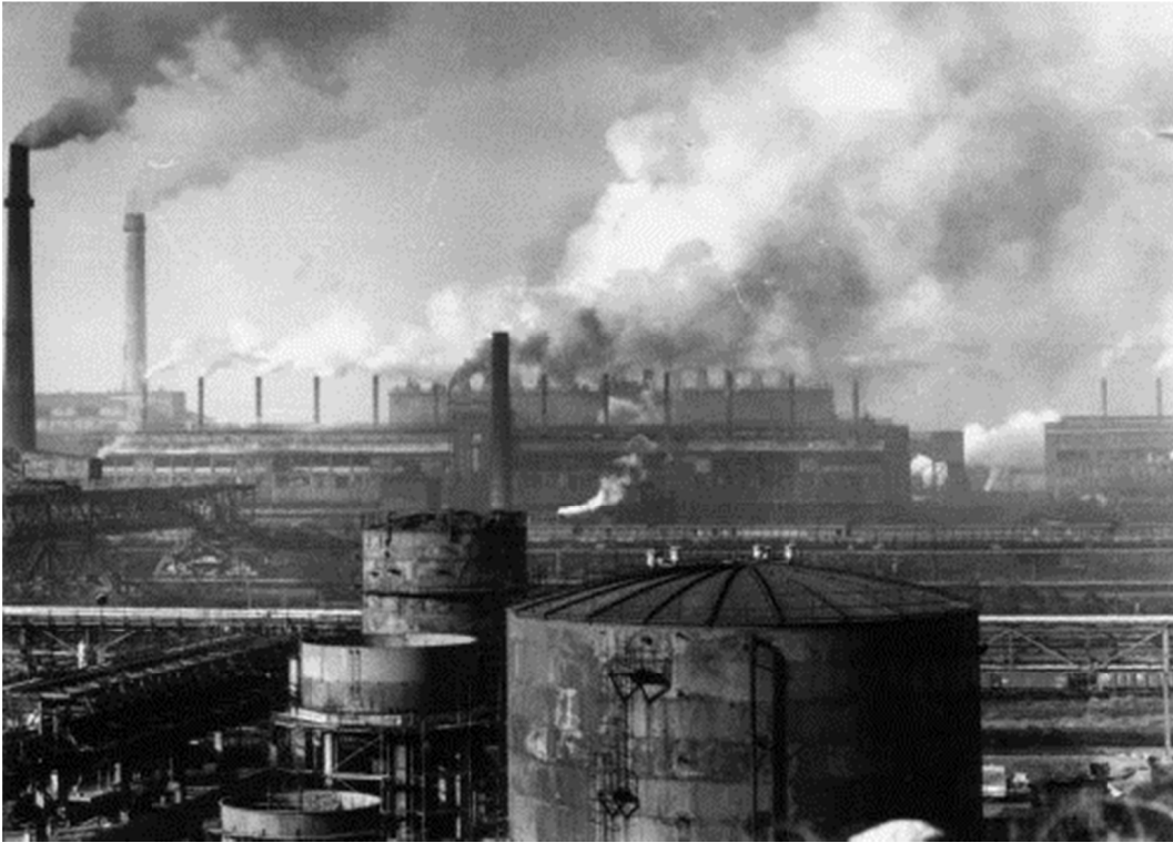
Blick über das Industriegebiet Espenhain. Die Brikettfabriken und das Braunkohleverschwelungswerk sind im Hintergrund. (Foto: www.nach-gedacht.de )
