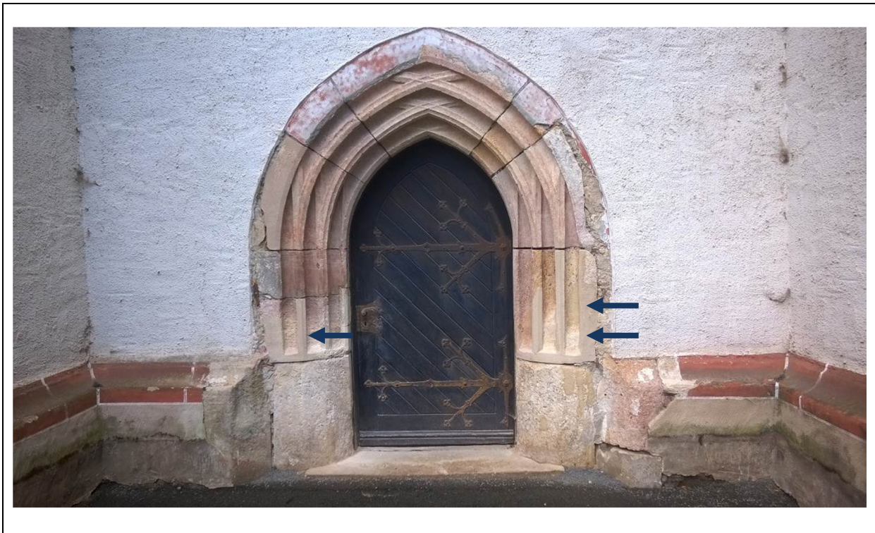
Abb. 20 Antragungen mit verschiedenen Steingängungsmörteln
