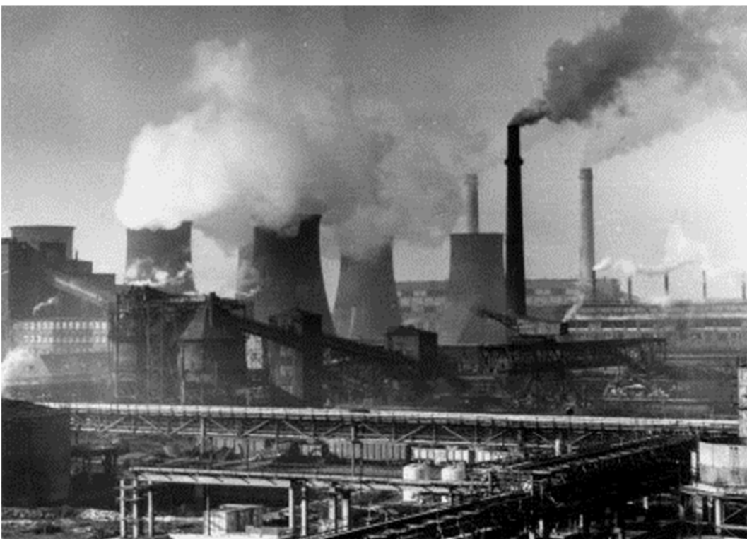
Braunkohlekraftwerk Espenhain (Foto: www.nach-gedacht.de )
