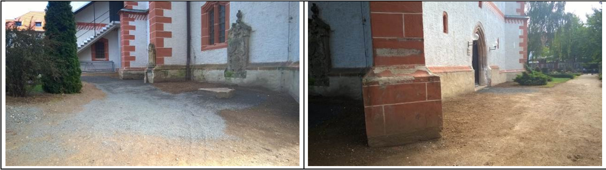
Abb. 25 Geländeregulierung im Bereich der Süd- und Westfassade
