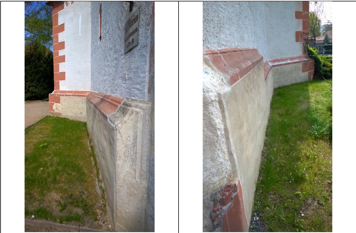
Abb. 31 Wiederbegrünung nach Einbau der Vertikalsperre auf Dernotonbasis und Geländeregulierung im Bereich der Westfassade. Kaschieren der notwendigen Abdeckplatten durch Rasen
