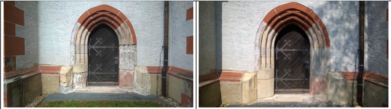
Abb. 32 Zustand des Südportals im Verlauf der Restaurierung: vor Antragung der Steingängungsmörtel (links) und nach Durchführung der Antragungen (rechts) mit den speziell entwickelten Mörteln
