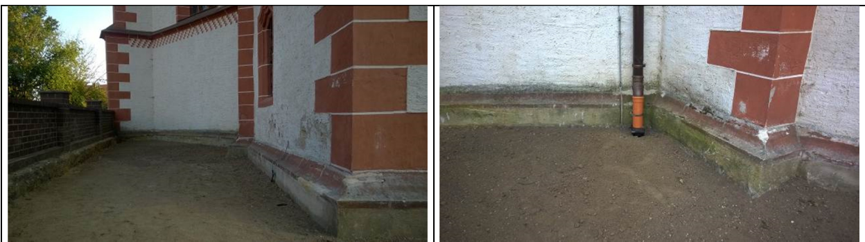
Abb. 28 Geländeregulierung im Bereich der Ostfassade, Erneuerung der Dachwasserabführung
