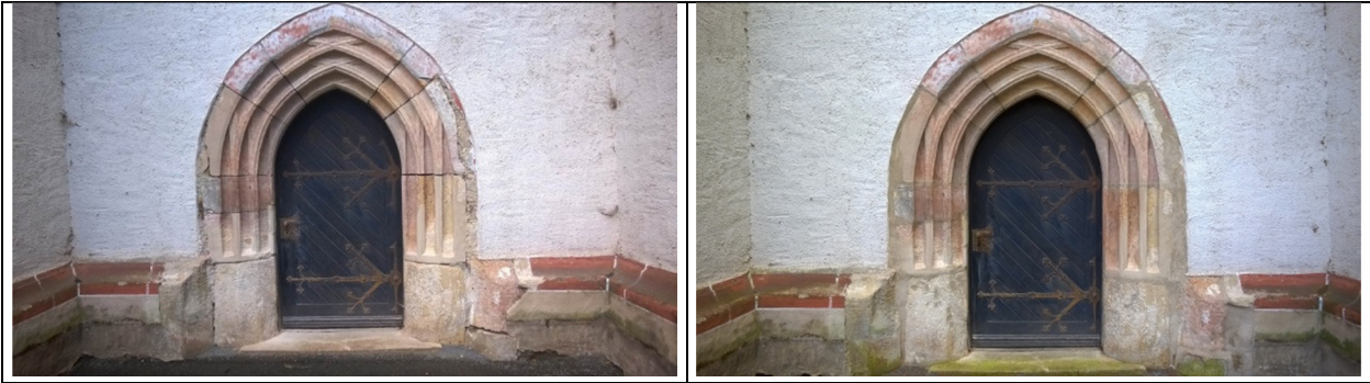
Abb. 29 Zustand des Nordportals im Verlauf der Restaurierung: nach Antragung der speziell entwickelten Steingänzungsmörtel (links) und nach dem Schließen der Fugen (rechts)
