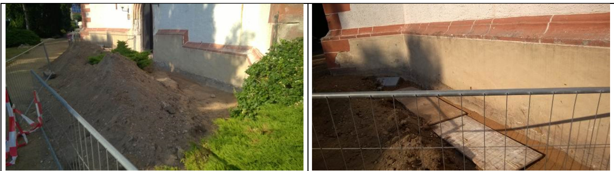
Abb. 24 Einbau einer Vertikalsperre auf Dornotobasis im Fundamentbereich
