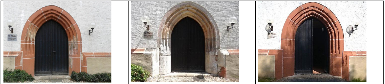
Abb. 34 Westportal vor, während und nach der Restaurierung
