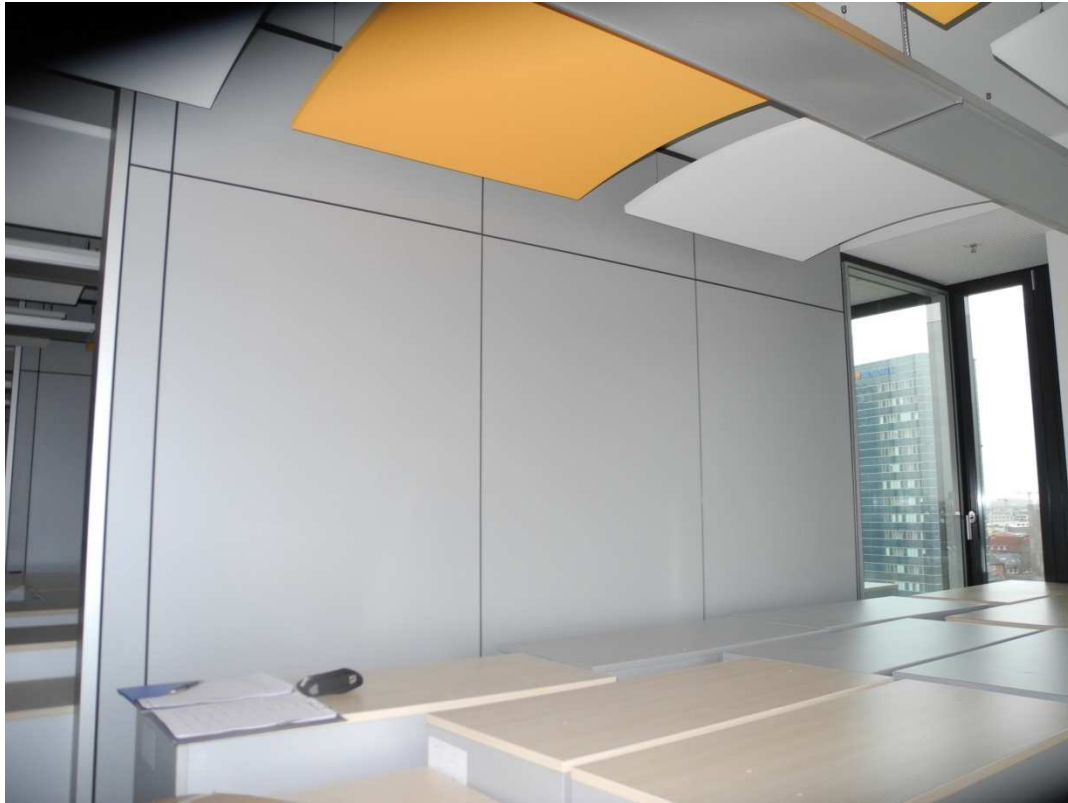
Abbildung 71: Trennwandsysteme 10 Jahre alt (Dechantsreiter)
