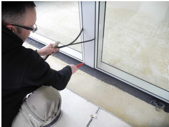
Abbildung 74: Systematischer bauteilorientierter Rückbau der Glastrennwände, Fa. Wiedow (Dechantsreiter)
