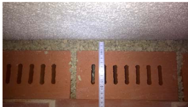
Abb. 15 Gottesgnaden, Kirche, Schiff, Nordwand mit neu eingebautem Lüftungstreifen
