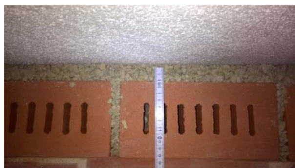
Abb. 8 Gottesgnaden, Kirche, Schiff, Nordwand mit neu eingebautem Lüftungstreifen
