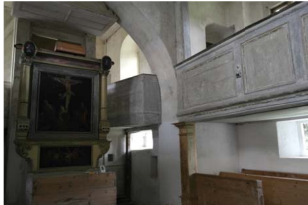
Abb. 1: Position des Klimadatenloggers an der südlichen Empore
