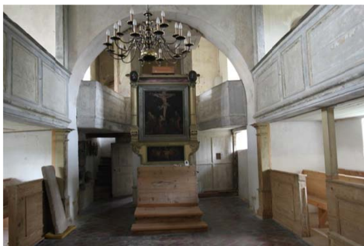
Abb. 1: Kirche in Ostrau, Innenraum: Rechts und links sind die Holzeinbauten für die Sitzplätze zu erkennen, an denen u.a. Holzfeuchtemessungen ausgeführt worden sind.
