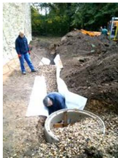
Abb. 12 Anlage der Rigole (Foto: Buchmann)
