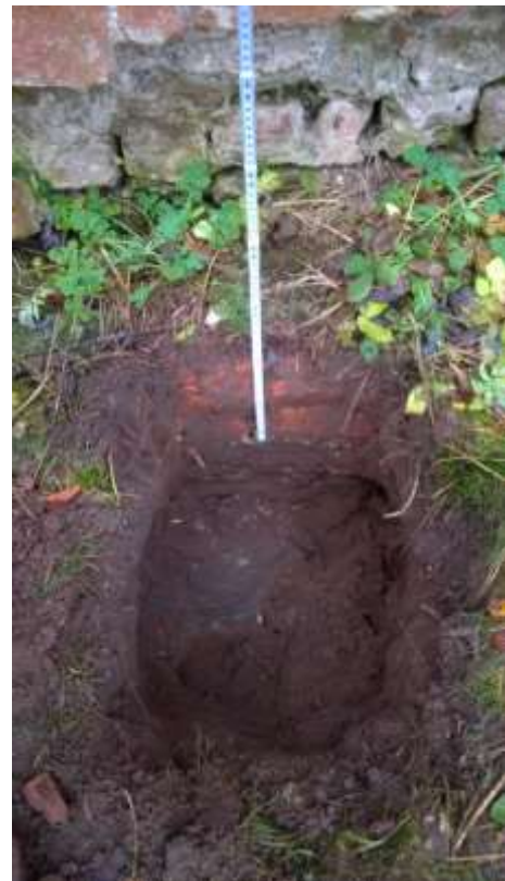
Abb. 7 Nordseite, Schürfe II außen, Probenahmepunkt SA, 40 cm unter GOK
