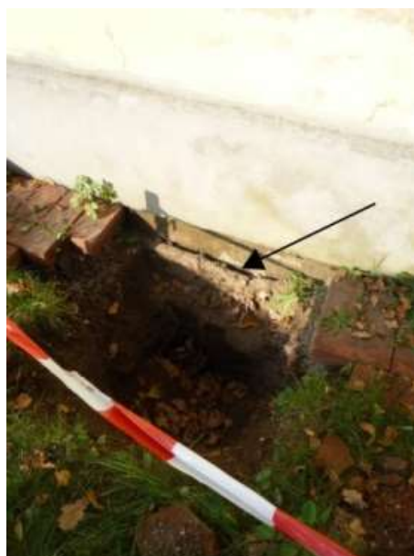
Abb. 5: Abstand der Tonplatte (Vertikalsperre) von der Wand, Südfassade
