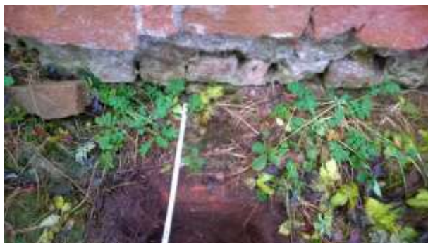
Abb. 8 Nordseite, Schürfe II außen, vorgesetztes Fundament
