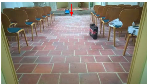
Abb. 1 Gottesgnaden, Kirche, Schiff, Blickrichtung Altar, Probenahmepunkt TP_AT
