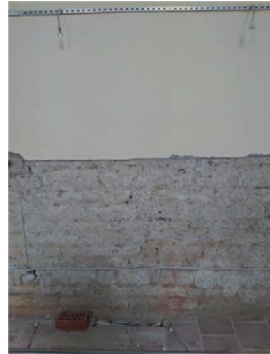
Abb. 17 Installation der Messfühler im Fußboden an der Nordwand
