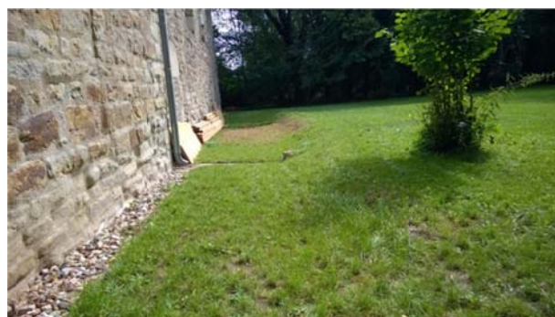
Abb. 24 Gottesgnaden, Kirche, Südfassade, Blickrichtung Ost, Rigole (Aufnahme am 08.08.2017)
