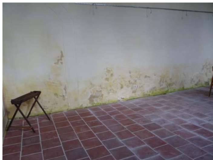
Abb. 2: Fußboden in der Kirche, der einen dichten Abschluss zum Untergrund schafft.
