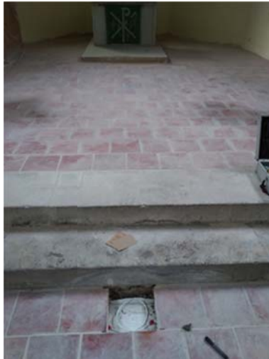
Abb. 16 Installation der Messfühler unterhalb des Fußbodens an der Treppe
