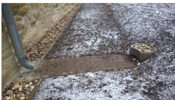
Abb. 21 Gottesgnaden, Kirche, Südfassade, Blickrichtung Ost, Ableitung des Regenwassers in die Rigole, (Aufnahme am 07.02.2017)
