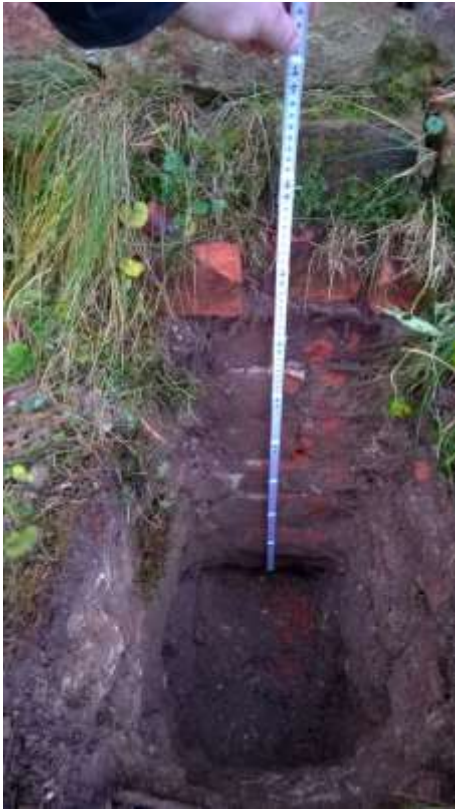
Abb. 4 Nordseite, Schürfe I außen, gegenüber Schürfe I innen, Fundamenttiefe: ca. 70 cm
