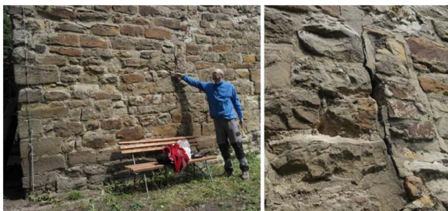
Abb. 7: Entnahmestelle der Setzmörtelprobe an der Nordseite des Turmes
