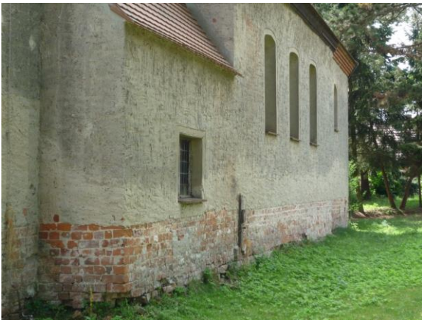
Abb. 16 Mulde an der Nordseite der Kirche Sydow
