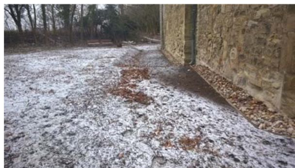
Abb. 20 Gottesgnaden, Kirche, Südfassade, Blickrichtung West, Rigole (Aufnahme am 07.02.2017)
