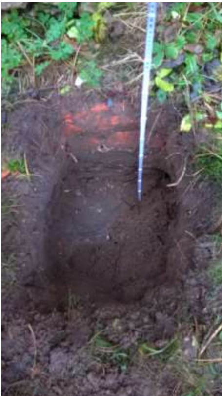
Abb. 6 Nordseite, Schürfe II außen, Fundamenttiefe: ca. 50 cm
