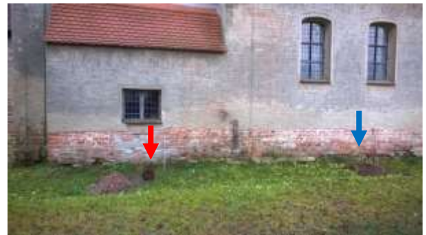
Abb. 3 Sydow, Kirche, Skizze, Anlage der Schürfe und Probenahmepunkte: roter Pfeil = Schürfe I innen und außen, blauer Pfeil = Schürfe II außen
