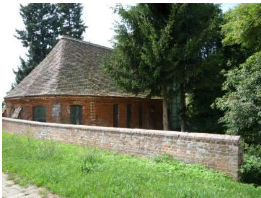
Abb. 1: Kirche in Räbel. Sie bindet mit dem Chor direkt in den angrenzenden Hochwasserschutzwall ein
