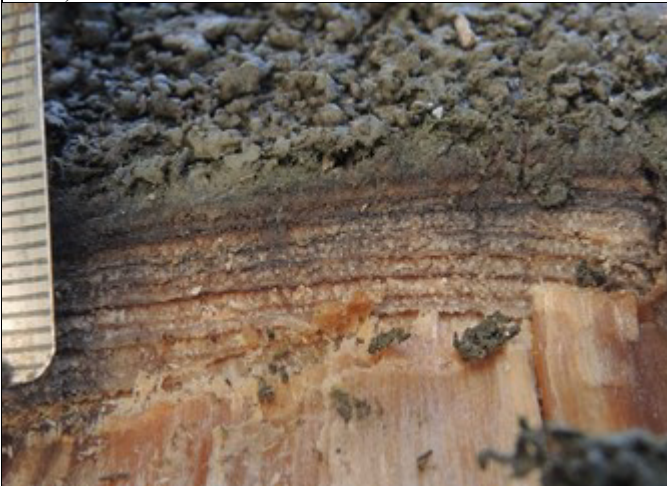
Abb. 23: Moderfäulepilze und Bakterienbeschädigungen, nach innen hin abnehmend; Maßstab in Millimetern; Fundstelle: P5: Yacht-Zentrum Störtebeker GmbH; Pfahl: 9 (U); 280 cm unter NN (Bild: T. Huckfeldt).
