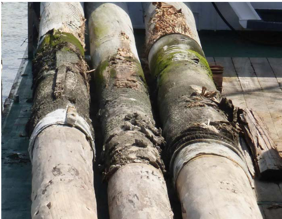
Abbildung 7: Bei der Entnahme zerstörte Holzoberfläche und eingerissenes Geotextil.
