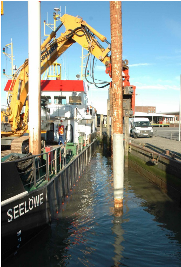
Abbildung 6: Rammen eines mit Geotextil ummantelten Reibepfahls in Harlesiel.
