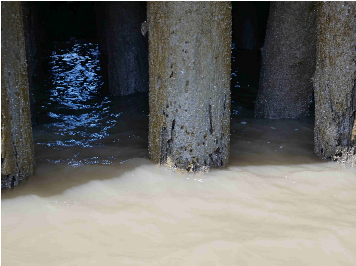
Abbildung 26: Unterbauten aus Holz im Bereich Geestemünde.
