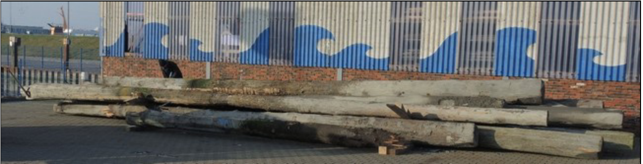
Abb. 14: Übersicht der Dalben an der Hafenstraße (Yacht-Zentrum Störtebeker GmbH); Probenahme: 22.01.2016 (Bild: T. Huckfeldt).
