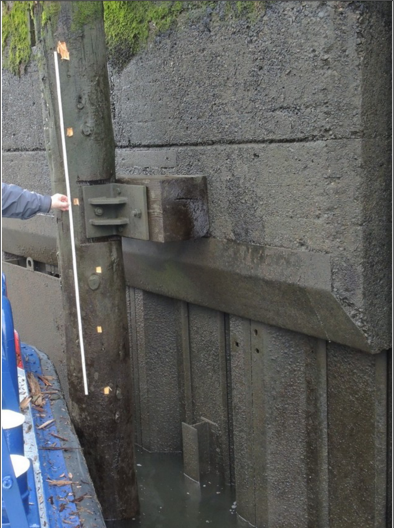
Abb. 18: Hamburg, Museumshafen, Am Sandtorkai; Südseite des Hafenbeckens, Dalbe (achte von Osten) mit Verteilung der Probenpunkte; erster Punkt ca. 60 cm über der Wasseroberfläche; Probennahme: 30.03.2017 (Bild: T. Huckfeldt).
