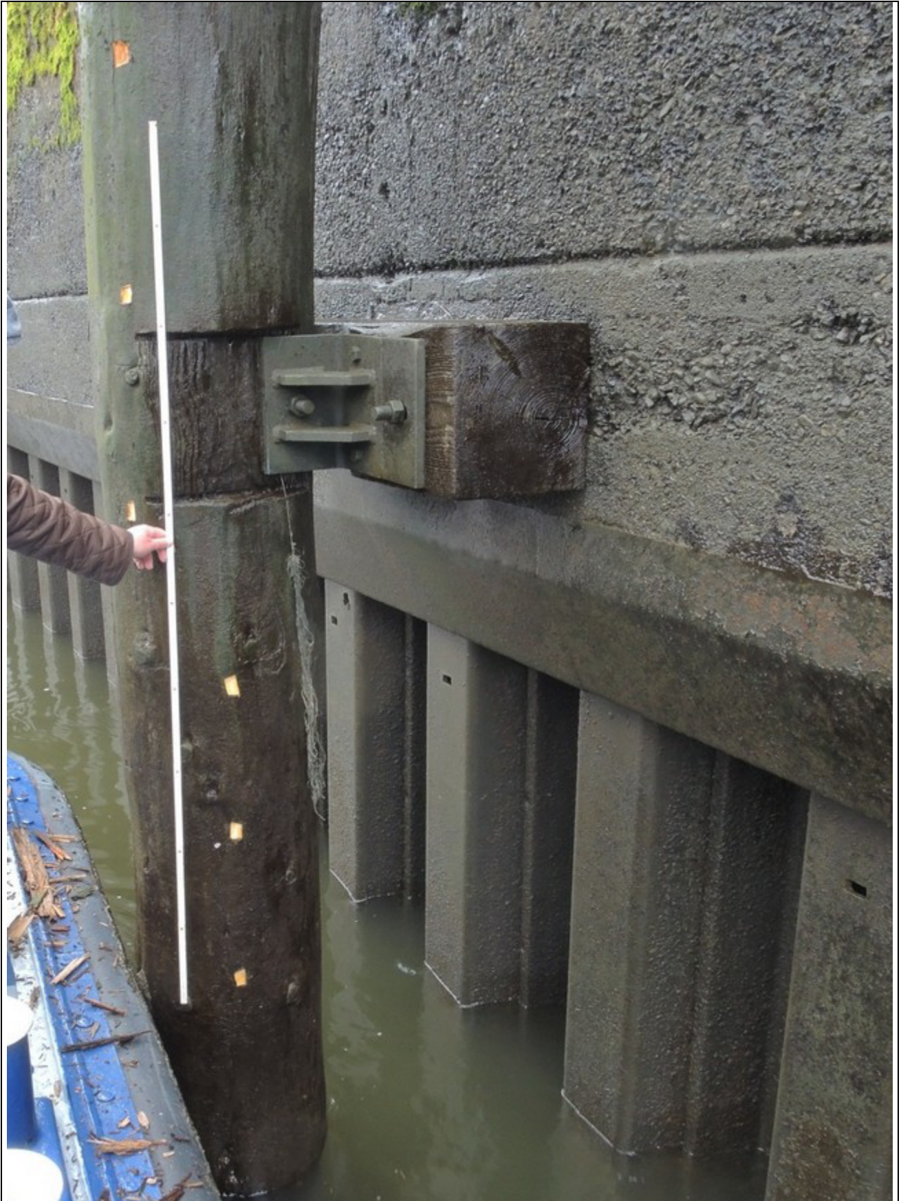
Abb. 19: Hamburg, Museumshafen, Am Sandtorkai; Südseite des Hafenbeckens, Dalbe (zweite von Osten) mit Verteilung der Probenpunkte; erster Probennahme-Punkt ca. 50 cm über der Wasseroberfläche; Probennahme: 30.03.2017 (Bild: T. Huckfeldt).
