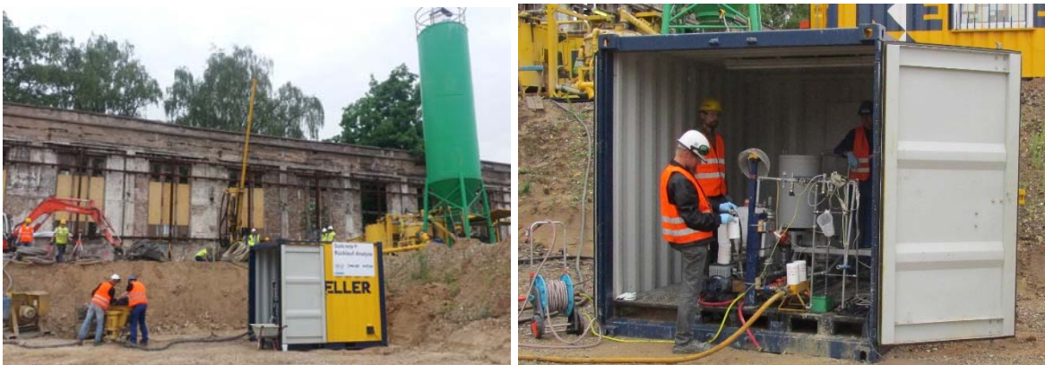
Abbildung 5-1: Erprobung auf der Baustelle links: DSV-Baustelle in Köln-Niehl; rechts: Messcontainer
