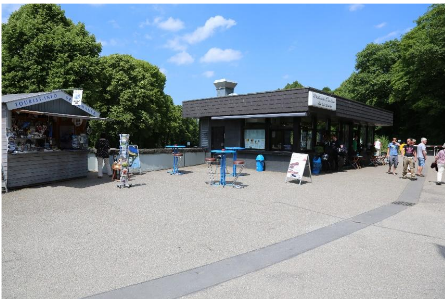
Infrastruktur auf der Staumauer
