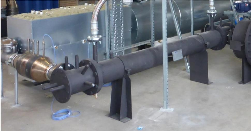
Abbildung 44: Abgaswärmeübertrager beim Einbau
