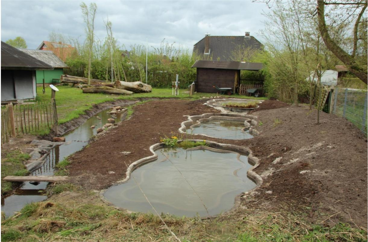
**Abb. 39:** Neuanlage der Fischzuchtteiche und Verlegung des Bachlaufs
