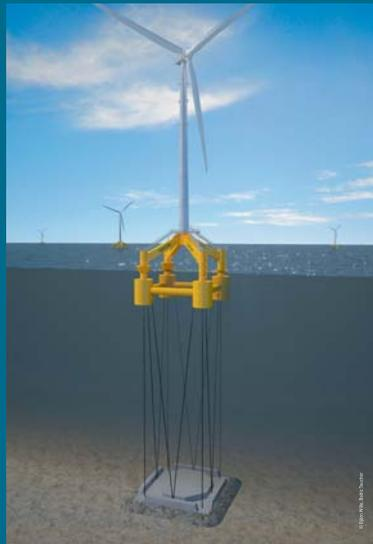
Schwimmendes Offshore-Fundament GICON®-SOF
