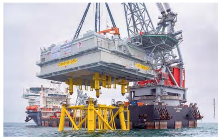
Erichtung Umspannstation auf Jacketfundamentkonstruktion durch Errichterschiff Oleg Strashnov
