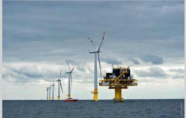
Offshore-Windenergieanlagen mit Umspannplattform bei windertreichem Wetter
