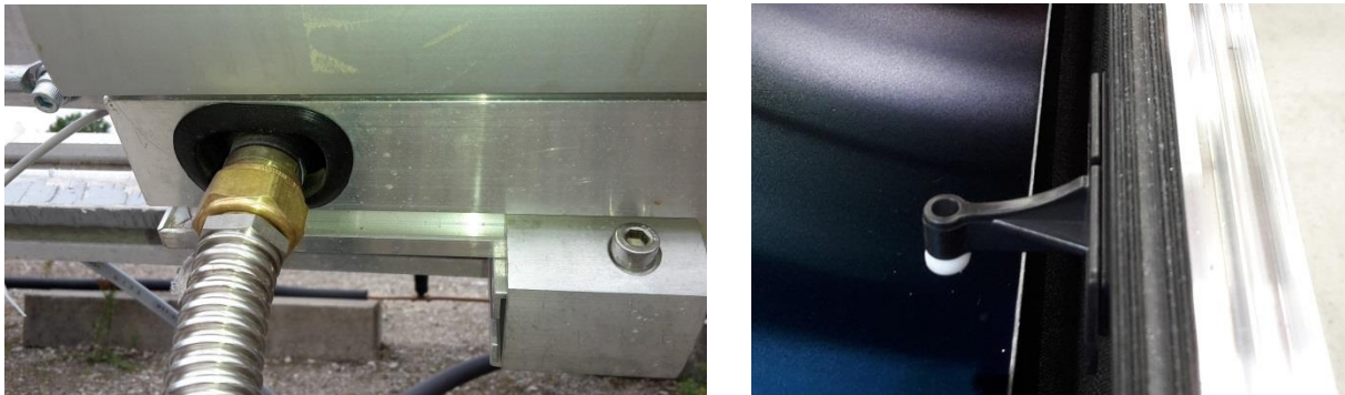
Abbildung 10: Neue flexible Anschlussdurchführung zur Aufnahme der temperaturbedingt verstärkten Längenänderung (links) und verlängerter (+ 10 mm) Absorberniederhalter (rechts).
