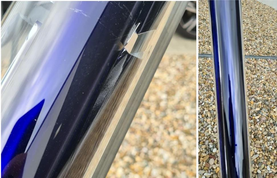
*Abbildung 134: Links Spiegelniederhalter und rechts Absorberbereich im Jahr 2021*
