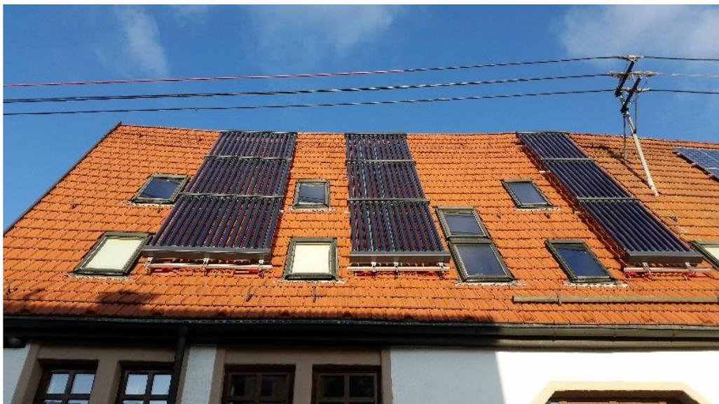
*Abbildung 127: Kundenanlage mit TSTair-Kollektoren - Schrägdach*
