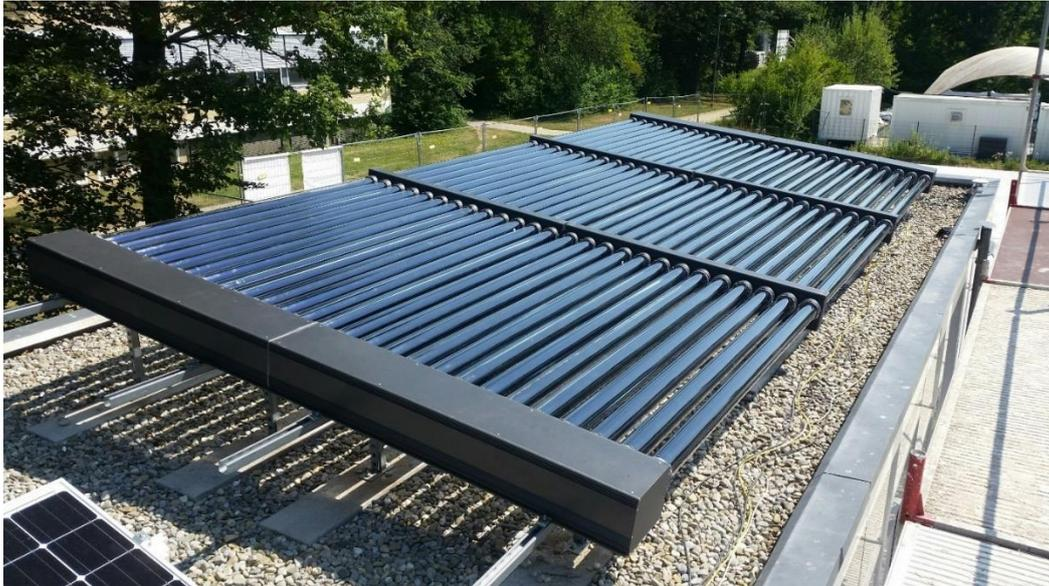
*Abbildung 132: Kundenanlage mit TSTair-Kollektoren - Flachdach*
