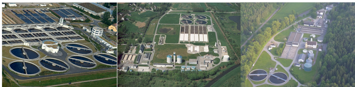
Abbildung 1: Kläranlagen von Dresden, Chemnitz und Plauen (von links nach rechts)
