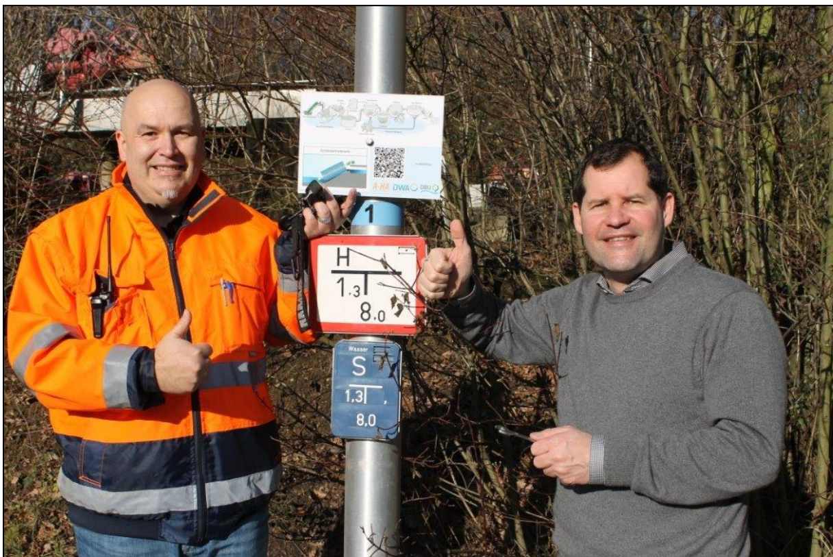
Abbildung 17: Montage der QR-Code Schilder auf der Kläranlage Köln-Stammheim
