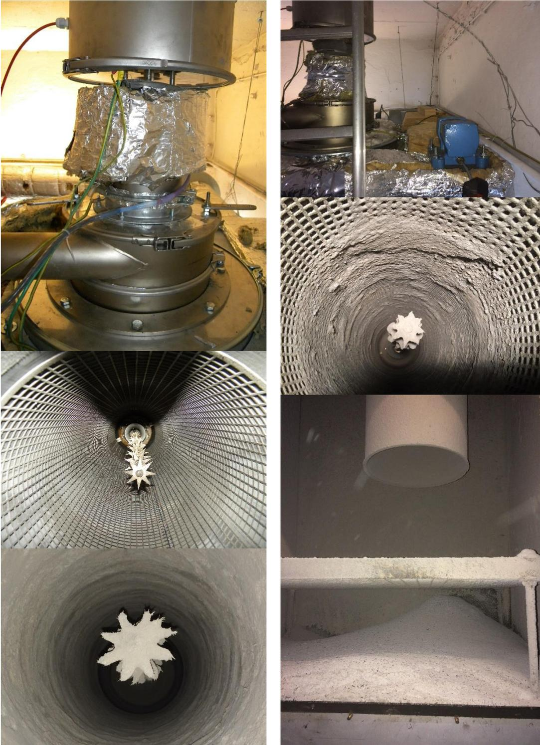
**Abb. 97:** Hochspannungseinführung mit Heizung und tangentialer Rauchgaszuführung o. li.; blauer Rüttelmotor zum Abklopfen der Ascheanlagerungen an Elektroden und Gehäuse o. re.; Aufladerrohr von innen mit Sprühelektrode und verschiebbaren Abreinigungsgitter m. li.; verdrecktes Abreinigungsgitter m. re.; Auflader im Betrieb mit Ascheanlagerung ohne Abreinigungsgitter u. li.; Ende des Aufladerrohrs und Gitterrost zur Strömungsberuhigung mit Aschebunker u. re.;
