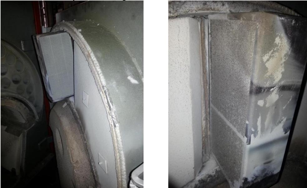
Abb. 42: Einpassung des SCR-Katalysators in die Kesseltür
