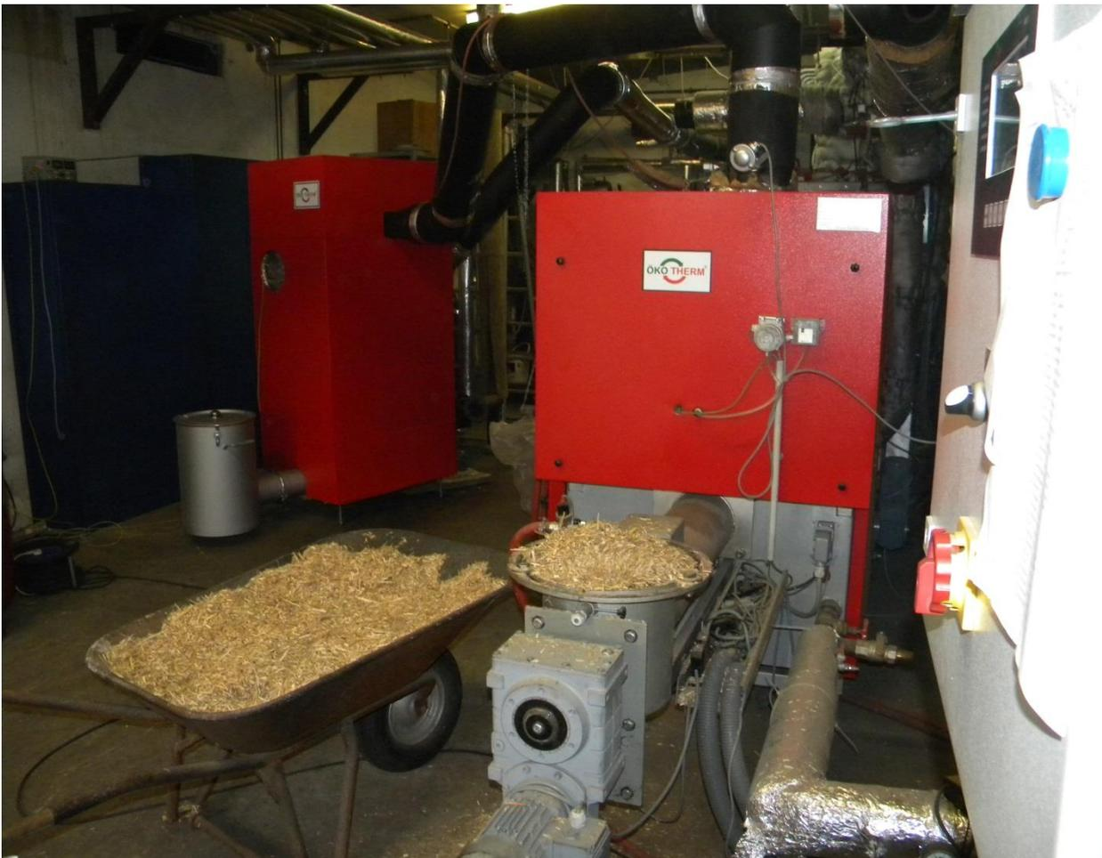
Abb. 113: Aufladermodul mit Abscheidebehälter li.; Kessel mit Miscanthusbrennstoff re.
