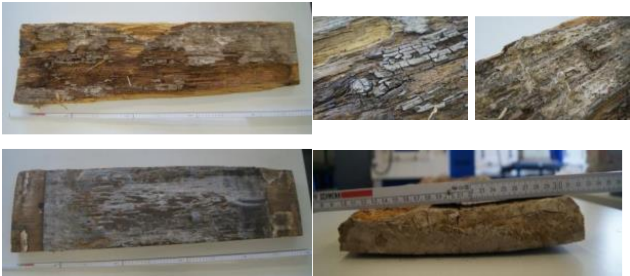
Abb. 51 Verschiedene Ansichten der behandelten Deckenbohle mit von Echtem Hausschwamm geschädigten Bereichen
