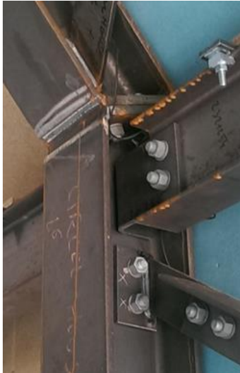
Abbildung 14: Verbindung von Baustahlkomponenten 92
