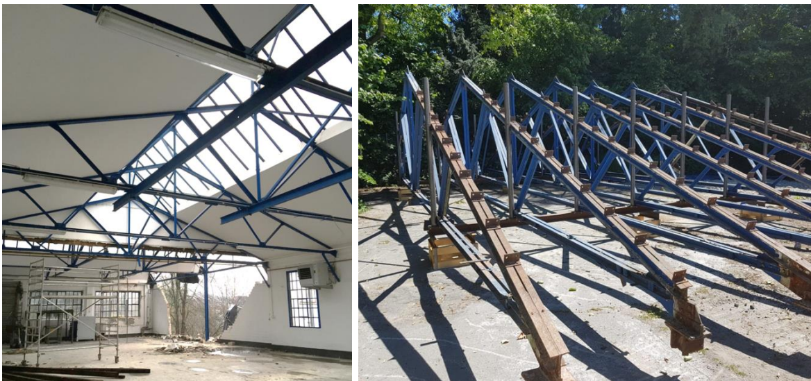
Abbildung 30: Fachwerkkonstruktion aus Baustahl 150
