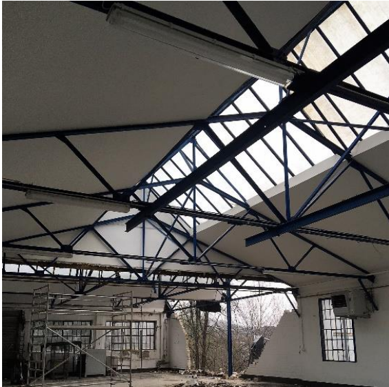
Abbildung 15: Verschweißte Fachwerkkonstruktion 94
