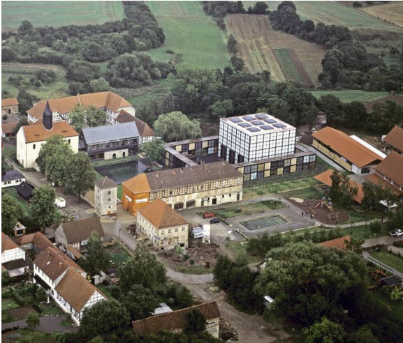
Abbildung 11: Wiederaufbau des Christus-Pavillons in Volkenroda, Thüringen 74
