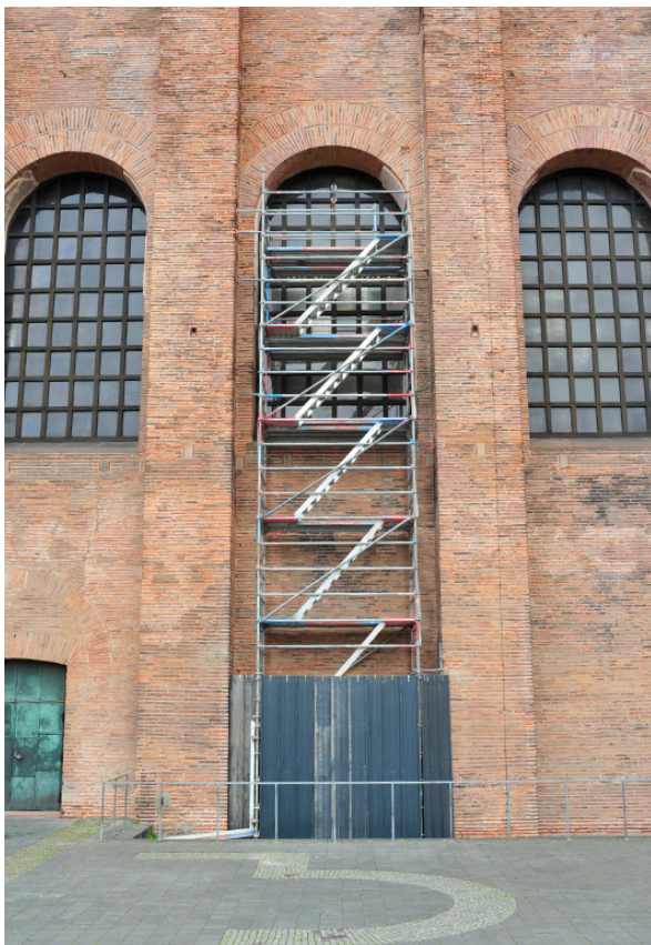
Abb. 36 Einrüstung der Probeachse Fensterlaibung W8 (2017)
