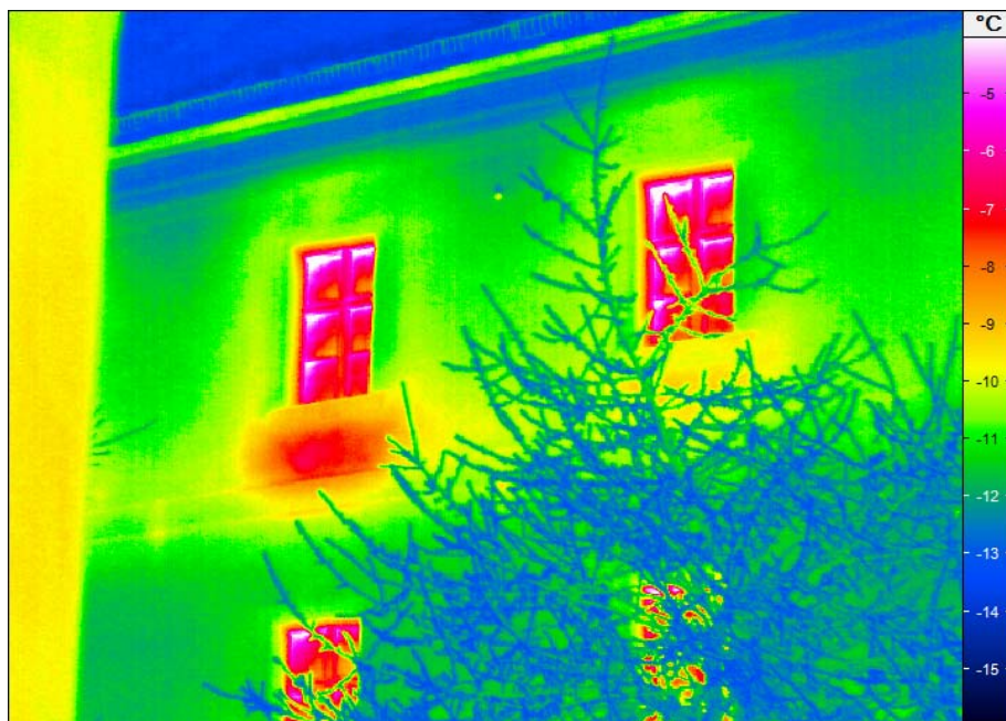
Bild 97: IR-Detaillaufnahme der Außenwand des Zimmers 2.29 (links) mit konventioneller Bauteiltemperierung.
