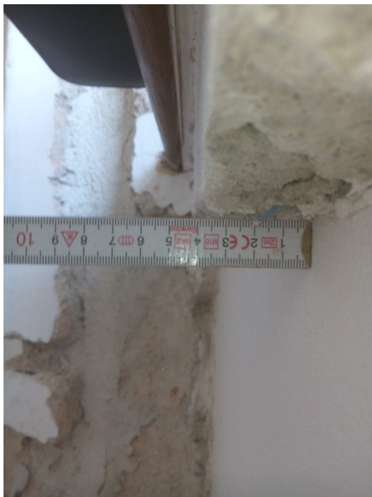
Bild 24: Detailaufnahme in der Fensternische in Zimmer 2.27. Die Nische ist mit Dämmputz 2 cm dick gedämmt. In den weiteren Putzaufbau mit 4 cm mit normalem Wandputz werden die Temperierrohre DN 18 mittig eingeputzt (Bild: HPE).
