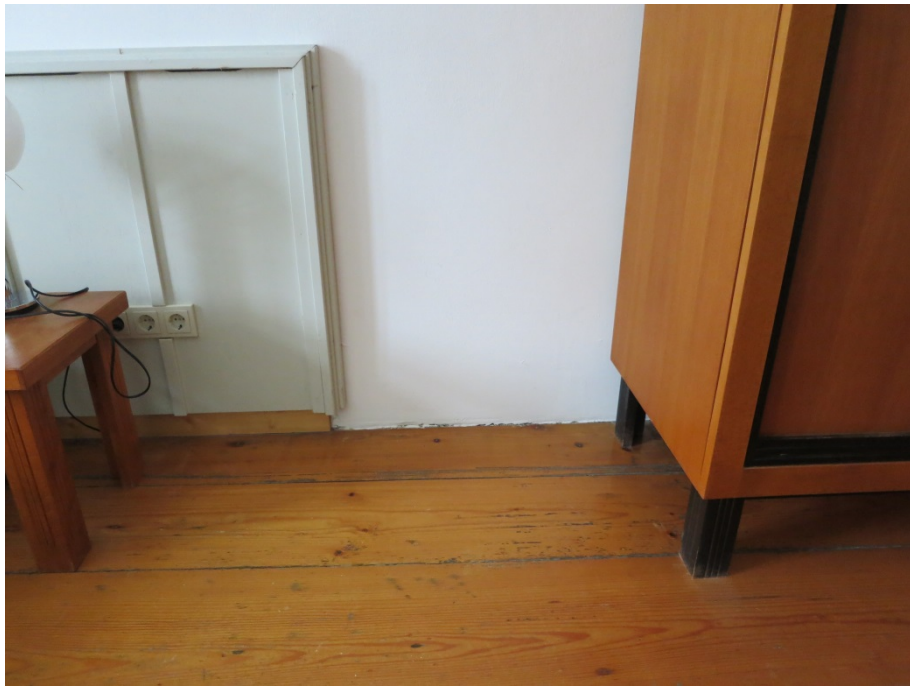
Bild 79: Ansicht der Innenwand im Raum 2.28 (Türnummer 204) angrenzend zum Raum 2.29 (Türnummer 203).
