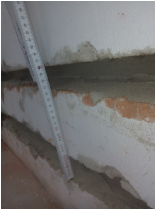
Bild 27: Detailaufnahme der vorbereiteten Schlitze im Zimmer 2.29. Die Schlitze wurden 4 cm x 4 cm groß hergestellt. Der Abstand der Temperierleitung beträgt ca. 16 cm im Achsmaß. Die Temperierung wird konventionell, d.h. ohne Dämmung, eingeputzt (Bild: HPE).
