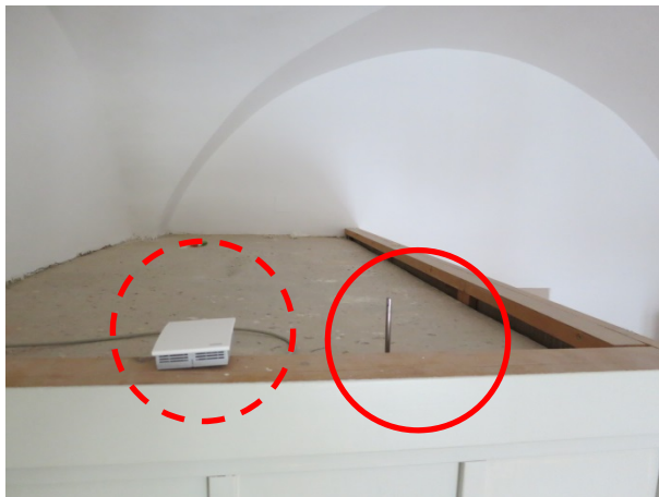
Bild 105: Detailaufnahme des Datenloggers (roter Kreis) mit Kombisensor im Raum 2.27 direkt neben dem Raumluftfühler des Messnetzes (Kreis gestrichelt).
