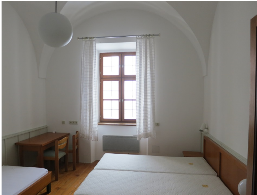
Bild 85: Ansicht der Außenwand mit Fenster im Raum 2.30 (Türnummer 202).
