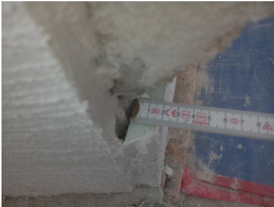
Bild 22: Detailaufnahme der Sockelsituation in Zimmer 2.26. Die Dämmstoffdicke beträgt 2 cm. (Bild: HPE).
