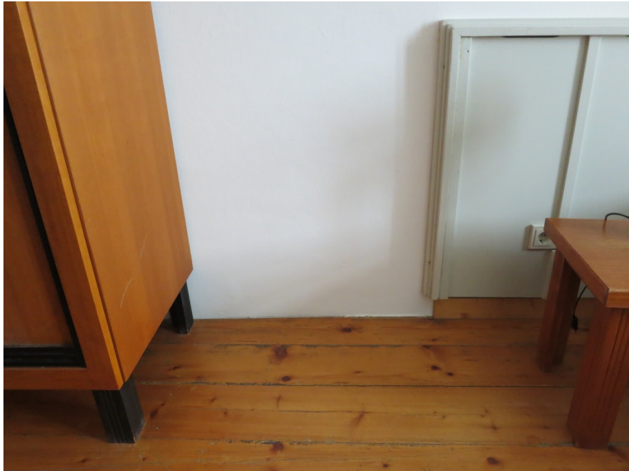
Bild 83: Ansicht der Innenwand im Raum 2.29 (Türnummer 203) angrenzend zum Raum 2.28 (Türnummer 204).
