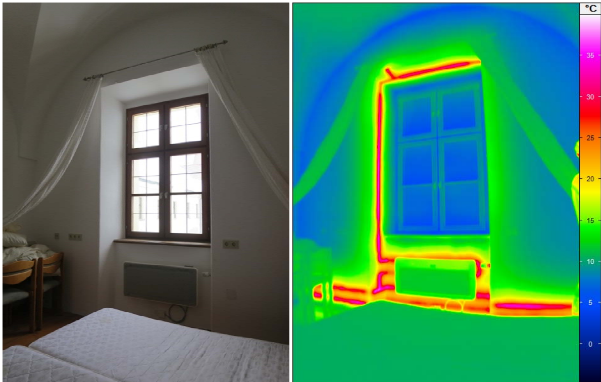
Bild 70: Außenwand mit Fenster und elektrischem Konvektor in der Fensternische im Raum 2.26 (Türnummer 206). Rechts ist die IR-Aufnahme des gleichen Bildausschnitts dargestellt. Die Außenwand wird mit einer Sockelschleife temperiert sowie mit einer zusätzlichen Heizschleife in der Laibung. In der Nische ist ein zusätzlicher elektrischer Konvektor montiert.
