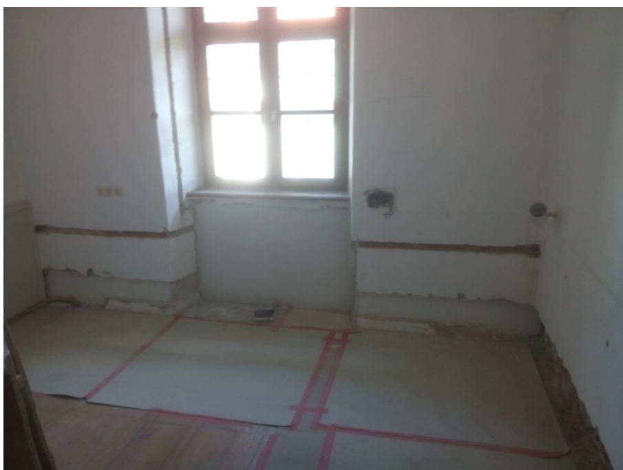
Bild 25: Unterer Wandbereich in Zimmer 2.28 mit bereits aufgetragenem Dämmputz in der Nische und im Bereich der Temperierung im Sockel (Bild: HPE).
