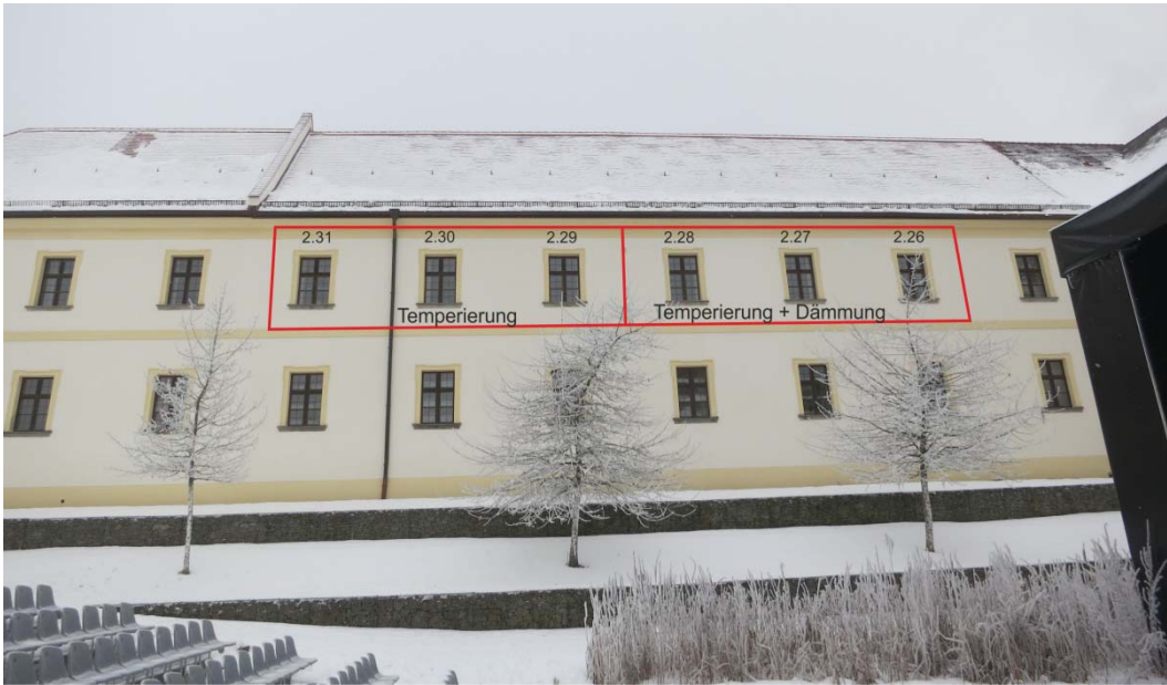
Bild 94: Nordseitige Außenaufnahme des Südflügels des Klosters. Im zweiten Obergeschoss befinden sich die untersuchten Räume mit konventioneller Bauteiltemperierung und gedämmter Temperierung.
