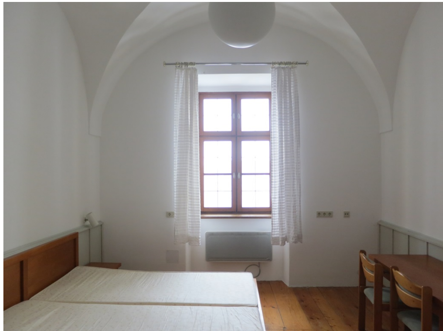
Bild 81: Ansicht der Außenwand mit Fenster im Raum 2.29 (Türnummer 203).
