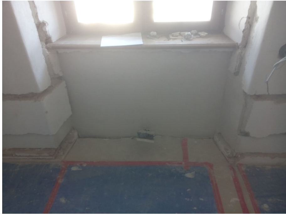
Bild 21: Ansicht der Fensternische im Zimmer 2.26 mit bereits eingebauter XPS Dämmplatte. Die waagrechten Schlitze in halber Höhe der Nische sind für die Elektroinstallation (Bild: HPE).
