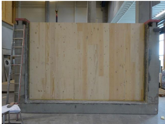
Abbildung 4-12: Schallmessung Trennwand - Bau des Prüfkörpers im Prüfraum
