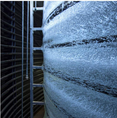
Abbildung 60: Energiepaket „Eis-Energiespeicher und Kraftdach“
