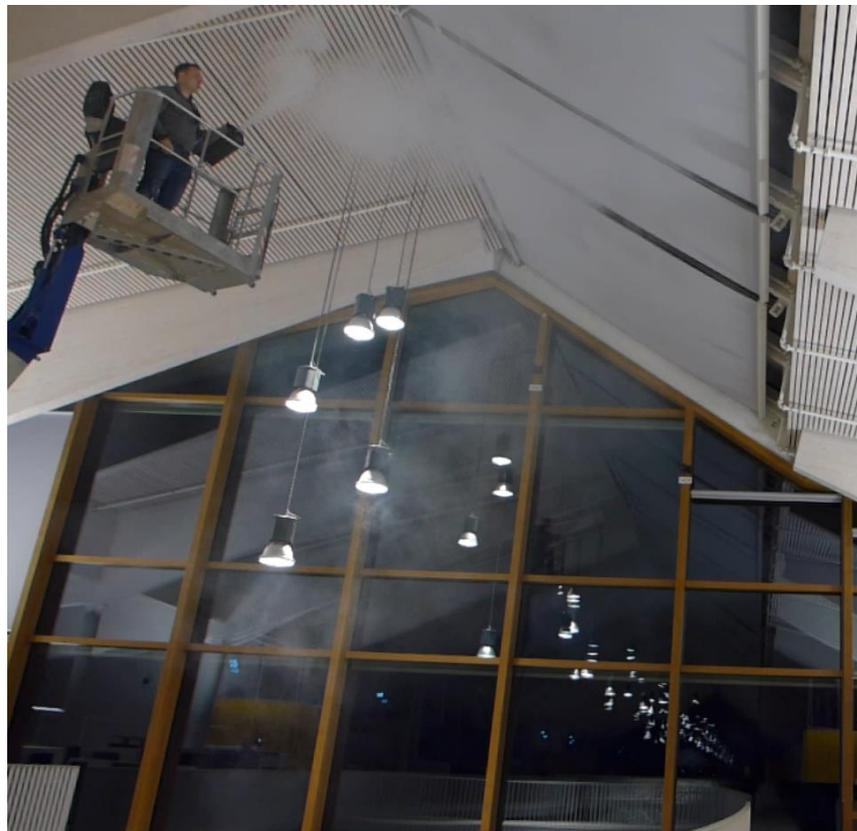
Abbildung 120: Rauchversuch an den Oberlichtern mit Blendschutz und Konvektoren
