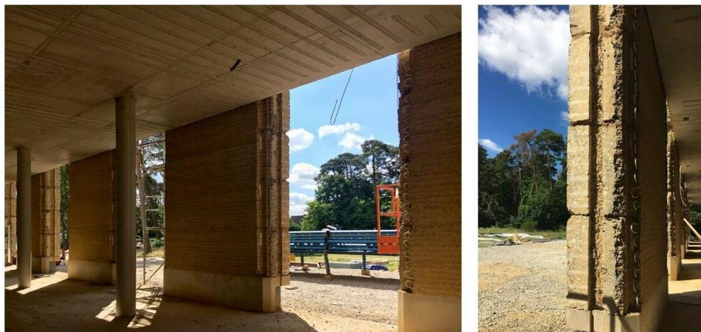
**Abbildung 11: Lehmwand während der Bauphase (links), Lehmwand thermische Aktivierung innen (rechts); Quelle: [www.transsolar.com](http://www.transsolar.com)**
