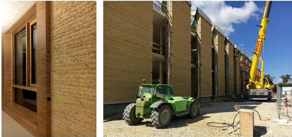
**Abbildung 12: Lehmwand nach Fertigstellung (links), Lehmfassade während Bauphase (rechts);
