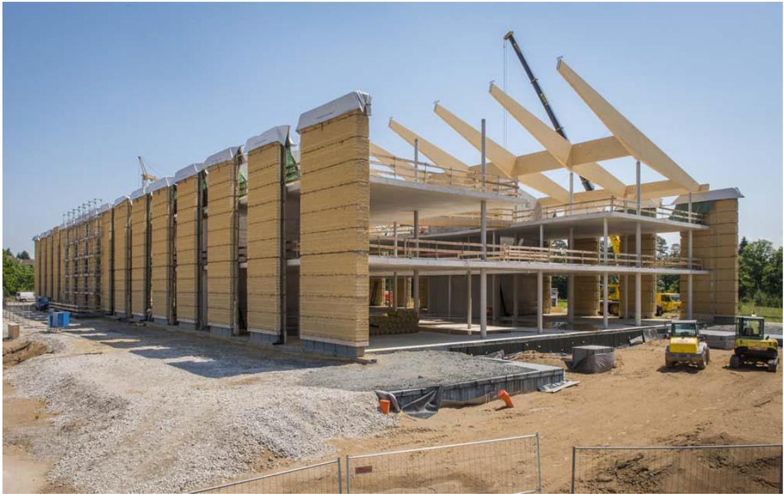
**Abbildung 7: Errichtungsphase, zweischalige gedämmte Lehmelemente, thermisch aktivierte Innenraumkonstruktion, Holzdach aus Leimbindern; Quelle: Marc Doradzillo**
