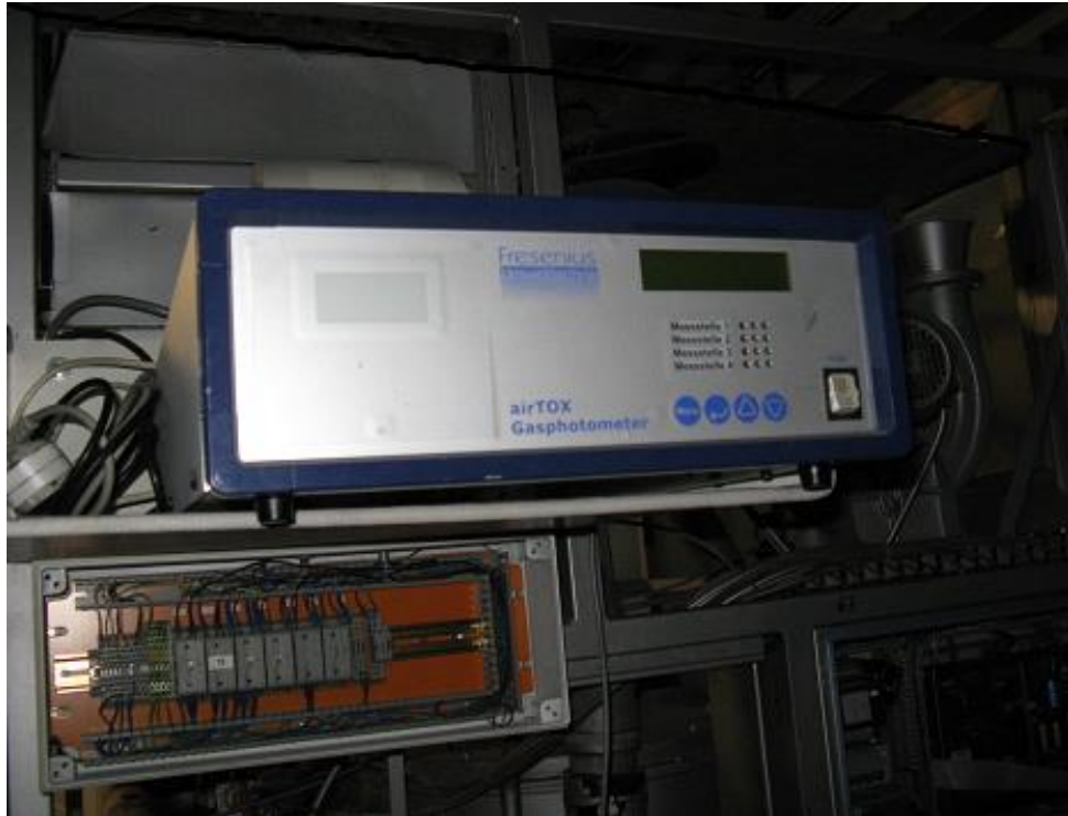
Abbildung 8: Vier-Kanal-Gas-Photometer mit Steuerungsfunktion zur Überwachung der Konzentration von LM-Gasen
