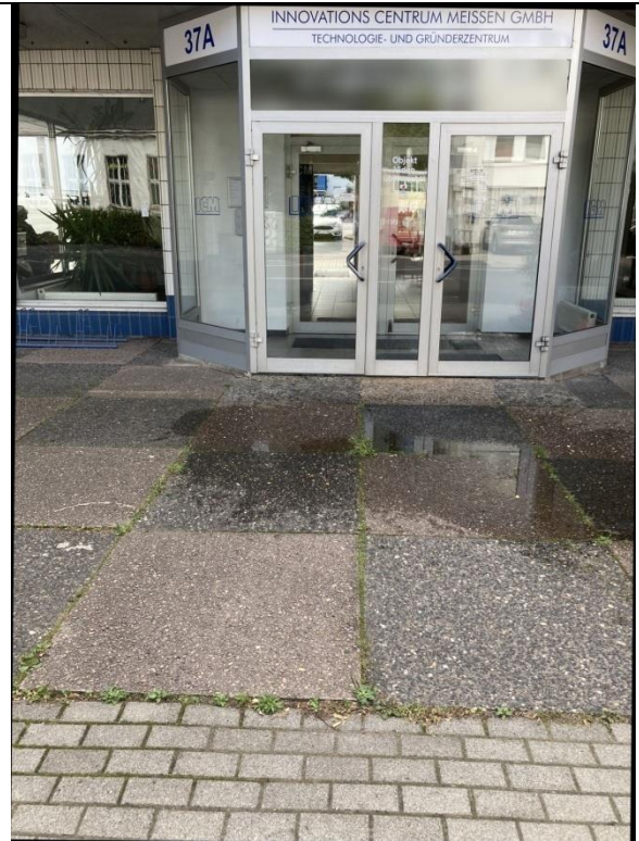
Bild 13: Demonstrationsfläche vor der Sanierung, 15s nachdem 10l Wasser aufgebracht wurden
