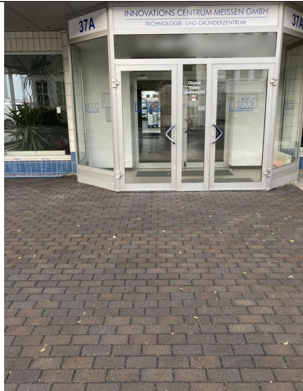
Bild 14: Demonstrationsfläche -trocken- nach der Sanierung
