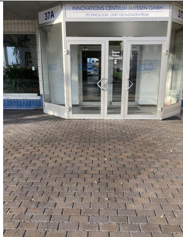
Bild 15: Demonstrationsfläche nach der Sanierung, 15s nachdem 10l Wasser aufgebracht wurden
