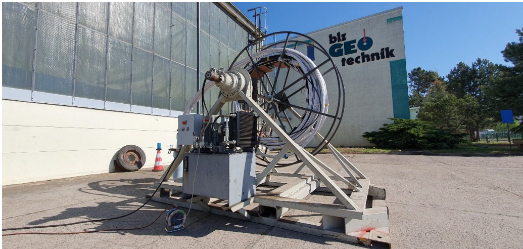
Abbildung 59: Wickelvorrichtung während des Sondeneinbaus an einer Testbohrung
