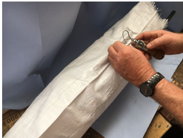
Abbildung 25: Manuelle Befestigung der Außenrohre an dem Gewebeschlauch
