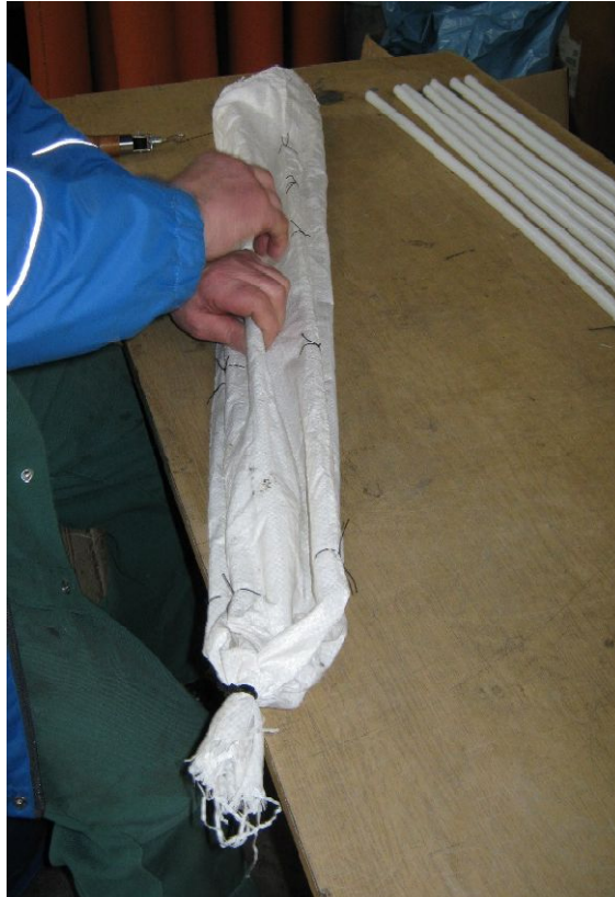
Abbildung 26: Am Gewebeschlauch befestigte Außenrohre
