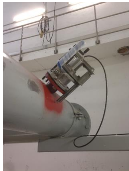
Abbildung 16: Feststoffsonde APW-Schmarl, Abwasser nach links fließend zur ZKA-Rostock
