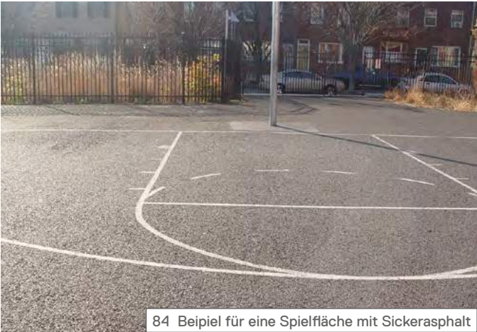
84 Beispiel für eine Spielfläche mit Sickerasphalt
