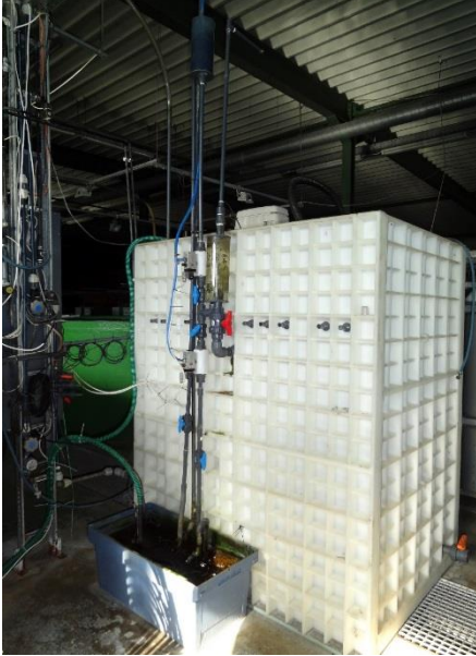
Abbildung 5: Detailansichten (Probenahmestellen) des ausgewählten Haltungskreislaufs in der Aquakultur-Kreislaufanlage am Standort Thierbach
