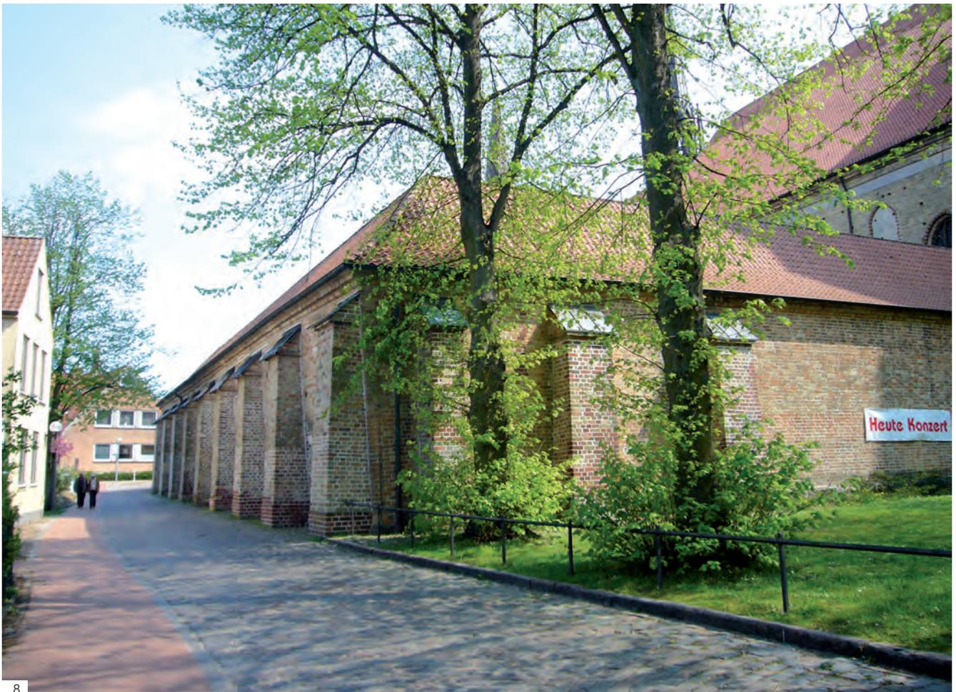
bis zu einer Tiefe von 1 m Zement eingebracht; insgesamt ca. 73 Tonnen. 1971/1978 wurden die Arkadenöffnungen wieder verschlossen. Nach einer ersten geschlossenen Version und den dadurch entstandenen Schäden an den Malereien (massive Schimmelbildung) entschied man sich dann, eine Teilbelüftung (umlaufende Lüftungsfuge) vorzunehmen (Abb. 10).
