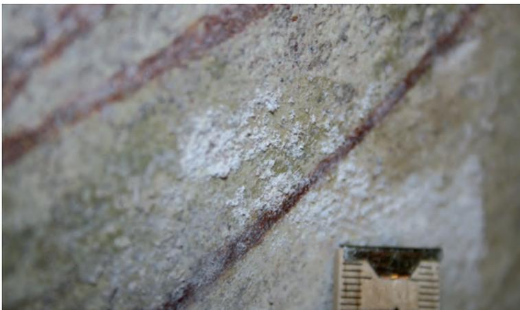
det. Durch die fortschreitende Entfestigung der Putzstrukturen resultieren Fehlstellen im Putz. Zu differenzieren sind mechanisch bedingte Fehlstellen (z.B. Einritzungen). Besonders im Bereich der Horizontalsperren bis hin zum Bodenniveau sind an allen Außenwänden großflächige Putzfehlstellen vorzufinden, welche auf salzinduzierte Schädigungsmechanismen zurückzuführen sind.
