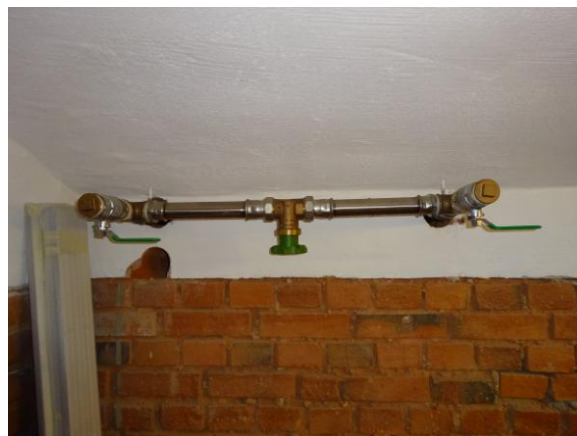
Abbildung 27: Vorbereitung der Wärmeeinspeisung. Zum Anschluss der Wärmerückgewinnungsanlage müssen später lediglich ein Ventil geschlossen und zwei geöffnet werden.
