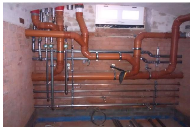
Abbildung 25: Vorbereitung der Grauwassererfassung. Vorerst wird das anfallende Grauwasser an einer Stelle in den Schmutzwasserkanal abgeschlagen, später wird die Leitung aufgetrennt und die Sieb-/Filtereinheit installiert.
