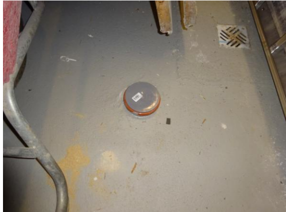
Abbildung 24: Aufstellungsplan zur Nachrüstung einer Grauwasserrecyclinganlage mit integrierter Wärmerückgewinnung. Auf dem Foto zu sehen: Die Raumentwässerung am tiefsten Punkt des Fußbodens und der Anschluss an die Kanalisation.
