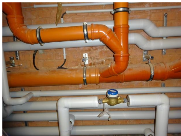
Abbildung 26: Vorbereitung der Betriebswassereinspeisung. Vorerst wird der Betriebswasserbedarf mit Trinkwasser abgedeckt, später wird die trennbare Verbindung gelöst und an deren Stelle die Trinkwassernachspeisung und die Verbindung der Grauwasseranlage zum Betriebswassernetz hergestellt.
