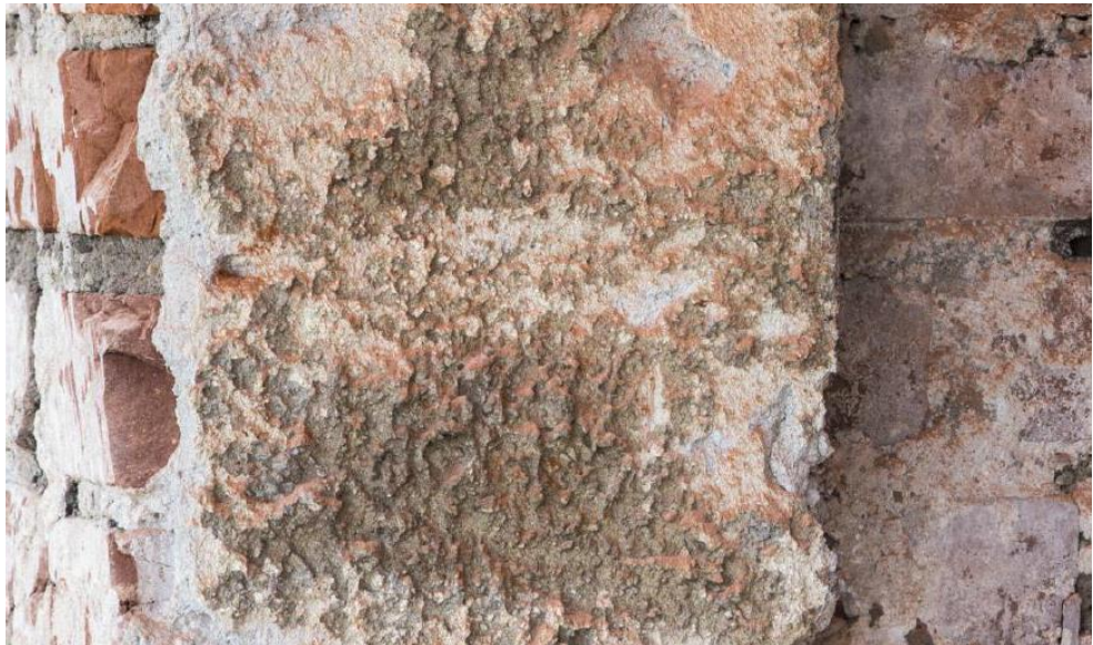
Bild 8: Photographische Ansicht des freigelegten, konkaven Original-Putzes von 1908 mit Mulden[Quelle: IBP].
