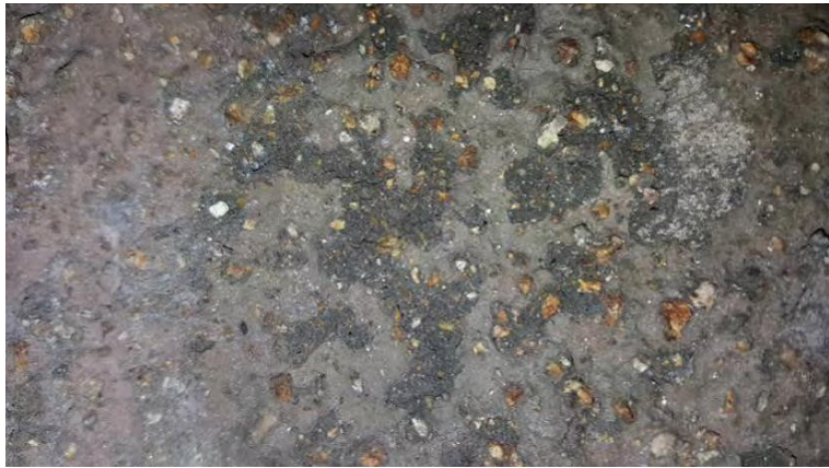
Bild 9: Photographische Ansicht des bauzeitlichen Putzes [Quelle: [3]].
