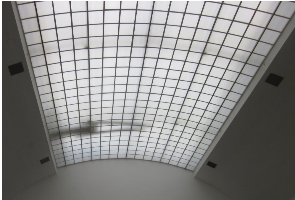
Bild 16: Lichtdecke im Bestand ohne speziellen UV-Filter [Quelle: IBP].
