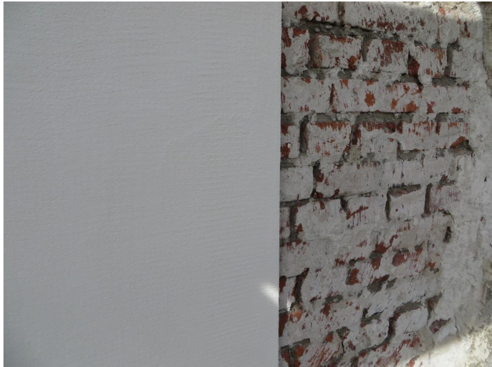
Bild 13: Darstellung eines Wandausschnitts – einmal mit und einmal ohne Putz [Quelle: IBP].
