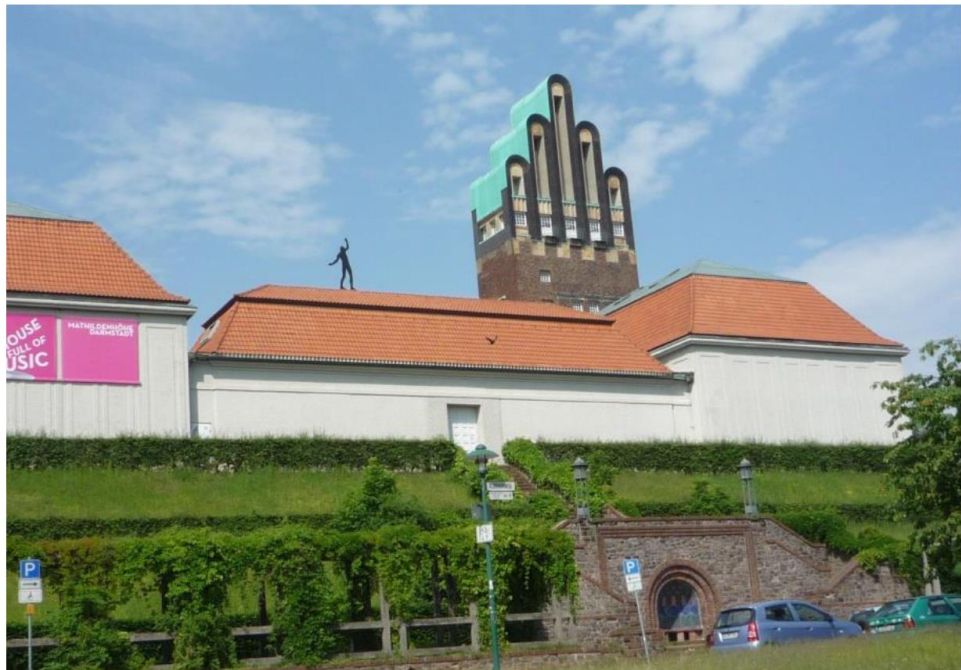
Bild 7: Photographische Ansicht der Westseite vor der Sanierung [Quelle: Schneider + Schumacher].
