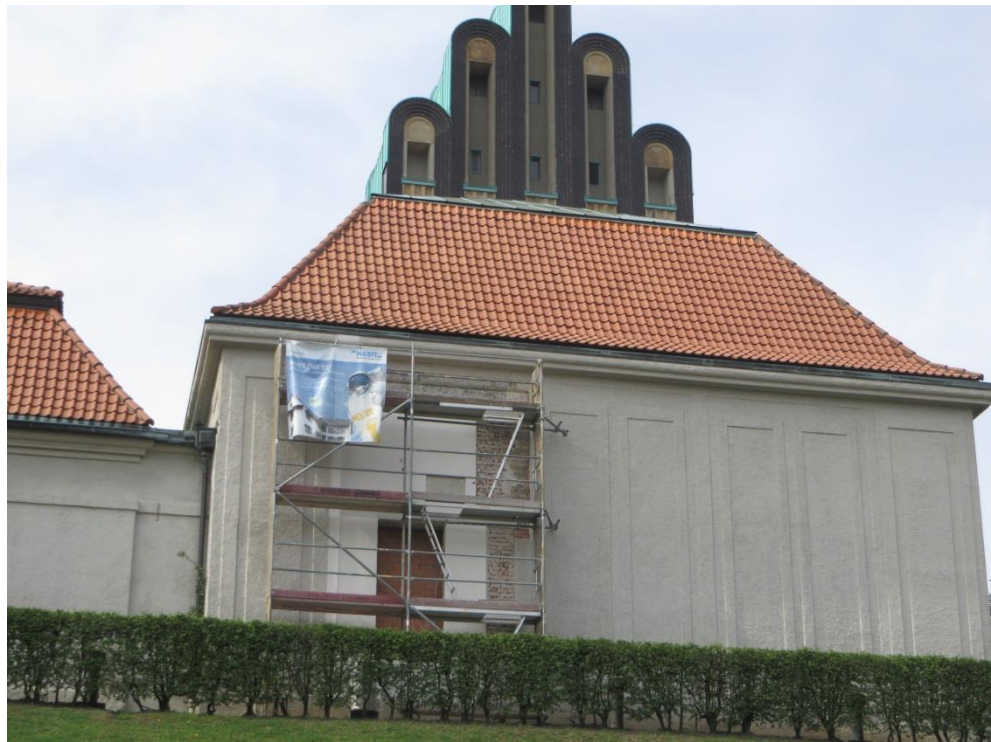
Bild 12: Photographische Darstellung der mit Aerogel-Dämmputz applizierten Musterfassade [Quelle: IBP].
