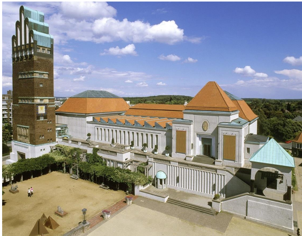
Bild 11: Photographische Aufnahme der Kunsthallen Mathildenhöhe vor der Sanierung[Quelle: Nikolaus Heiss] .
