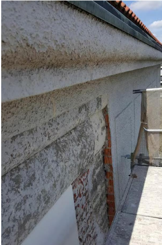
Bild 10: Photographische Ansicht einer partiell freigelegten Wandfläche. Es ist die ursprüngliche Lisene hinter der freigelegten Vormauerung zu erkennen [Quelle: [3]].
