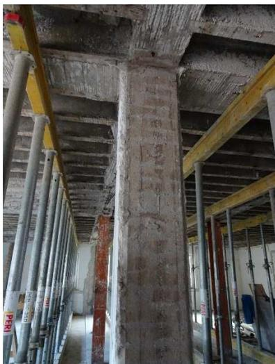
Abb. 126: Stütze aus R-Beton
