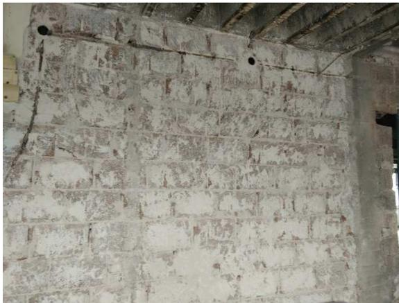
Abb. 124: Flurwand aus Mauerwerk mit R-Betonsteinen
