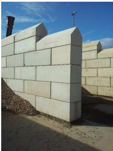
Abb. 137: Ökostones als Betonmauersteine für Silowände
