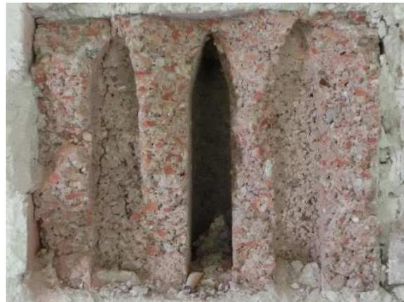
Abb. 125: R-Betonmauerstein
