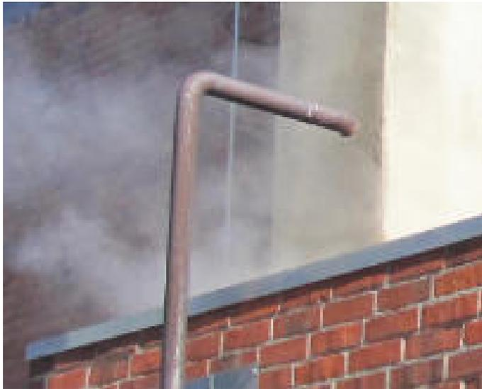
Abbildung 29: Wrasendampfrohr mit Schwadenbildung
