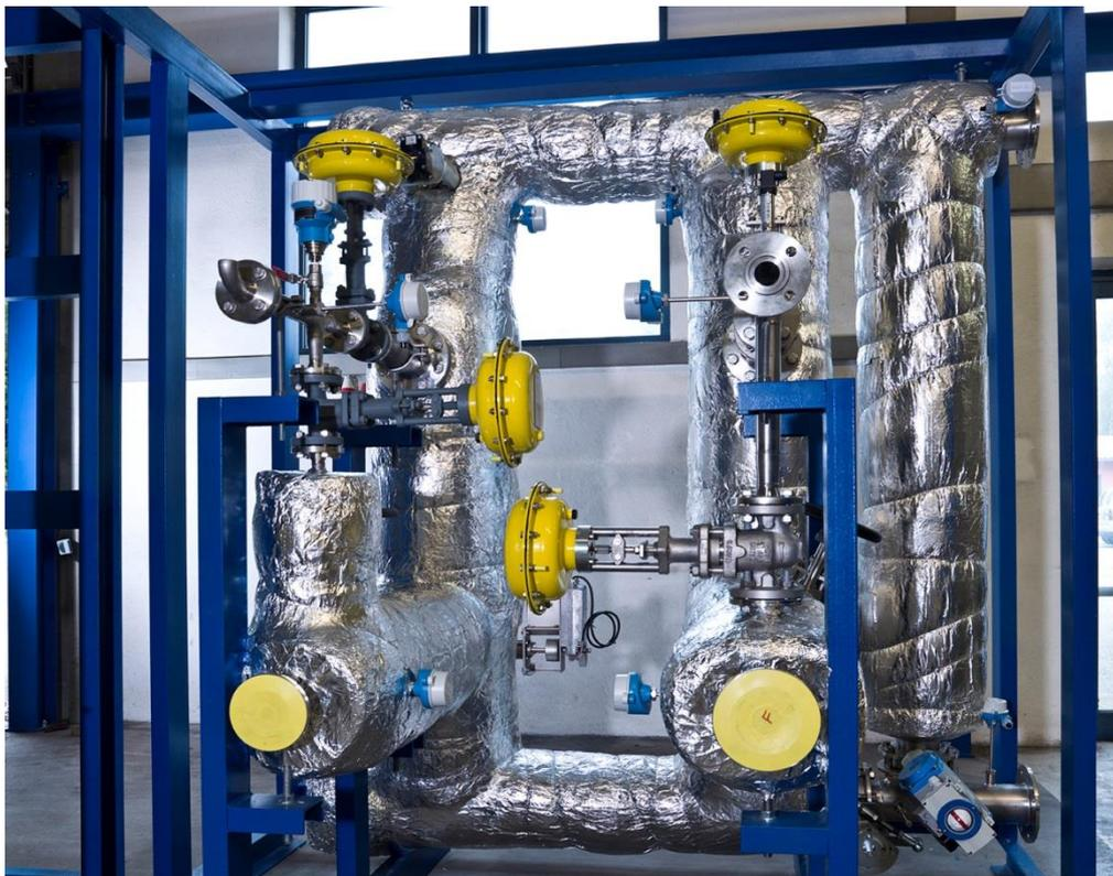
Abbildung 2.3: Modul Sauerstoff-Brennstoff-Vorwärmung (Quelle: UAS Messtechnik GmbH)
