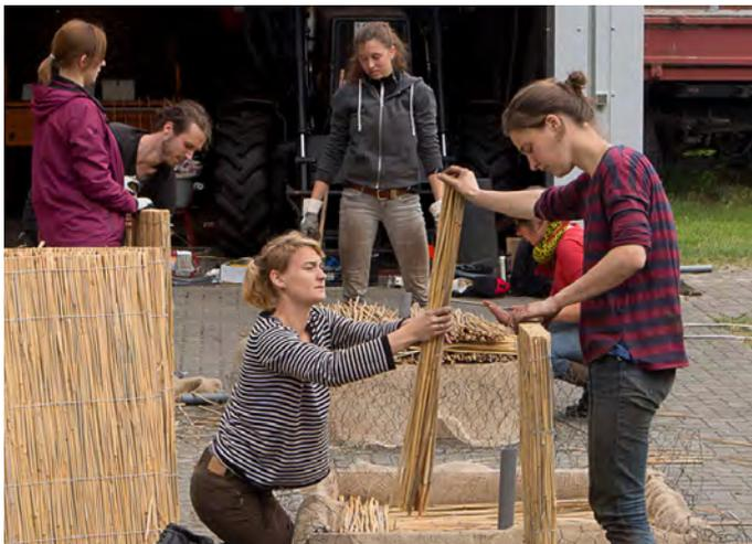
Abbildung 25. Entnahme der Halme aus den Schilfrohrplatten und Einlegen der Halme in die Rahmen zur Herstellung der Gabione.
