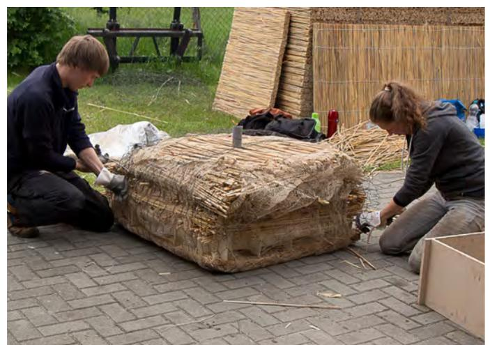
Abbildung 28. Fertiggestellte Schilfrohrgabione (45 cm Aufbau). Das Drahtgitter wurde auf der Oberseite und an den Seiten ineinander verknüpft, um die Gabione fest zu verschließen.
