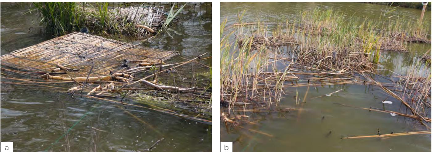
Abbildung 75. Nachdem das Drahtgitter an den Seiten verrostet war, haben sich die Schilfplatten gelöst und sind hier mit den eingesetzten Schilfrhizomen aufgeschwommen (a). Die Halmlagen haben sich gelöst und die einzelnen Halme schwimmen zwischen den übrigen Gabionen innerhalb des Rahmens (b).
