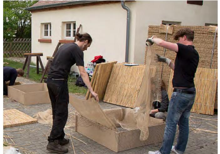
Abbildung 24. Einlegen des Drahtgewebes und des Jutegewebes in den Rahmen.
