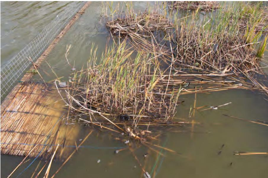
Abbildung 65. Das Drahtgitter der Gabionen ist verrostet und die Halmschichten sowie die untere Platte haben sich gelöst (links), weil die Gabionen noch nicht vollständig durchwurzelt waren. Die durchwurzelt Halmschichten, einzelne Halme sowie die Schilfplatten schwammen weiter auf dem Wasser (07.10.2016).
