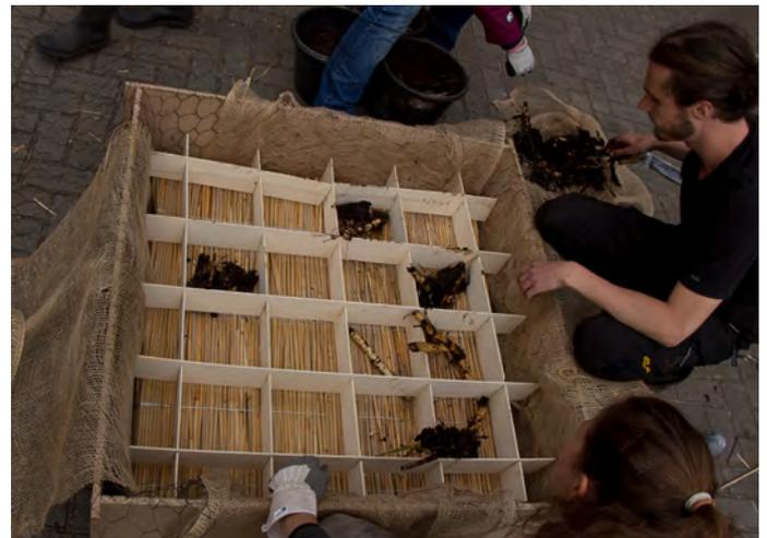
Abbildung 26. Einsetzen der Kammerung aus 4 mm dicken Pappelholz Brettern auf die unterste Schilfhalm-lage und Einlegen der Rhizomstücke in die Kammern.
