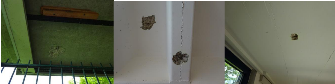
Abbildung 7: Aufschlüsse der Betondecken zur Feststellung der Feuerwiderstandsdauer [Architekten Keß und König]
