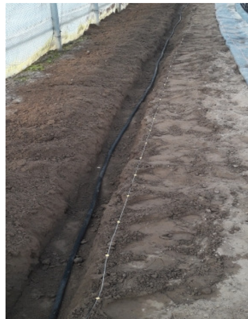
Abbildung 12: im Folientunnel verlegter Perlschlauch
