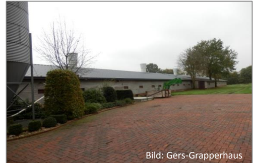
Putenstall mit neuer Dacheindeckung (Thermopaneele 60 mm)
