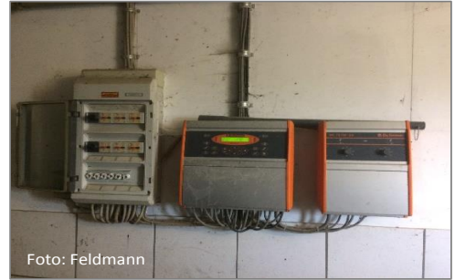
Alte Regeltechnik der Lüftungsanlage
