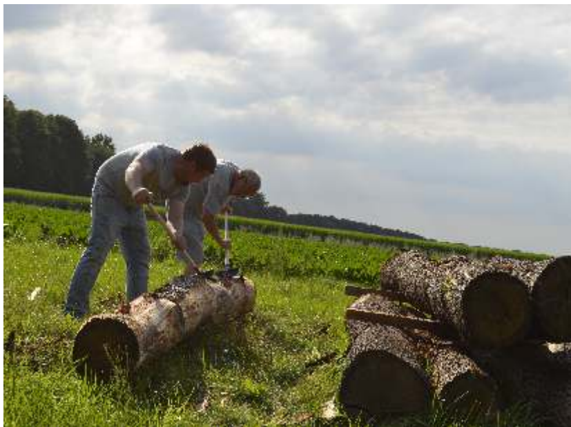
Abb. 4: Entrinden des Stammholzes vor dem Baubeginn
