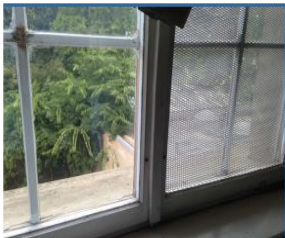
Blick auf ein Fenster des Maritimen Museums Blick auf Versuchsmontage Streckmetall im Josefinum
