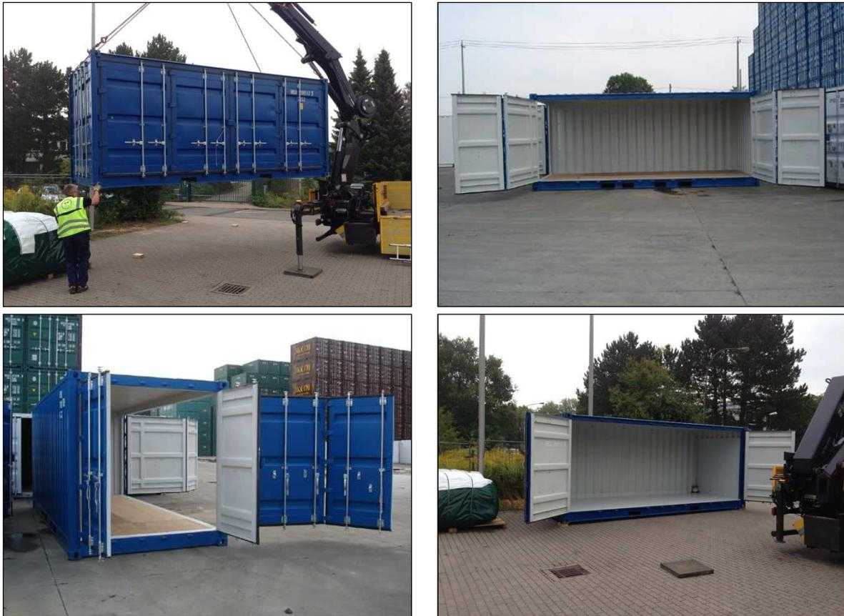
Abb. 17: Seecontainer Anlieferung (oben links) und Originalausstattung (oben links, unten rechts) so wie nach dem projektgerechten Umbau (unten rechts) – Betriebshof DAEDLER
