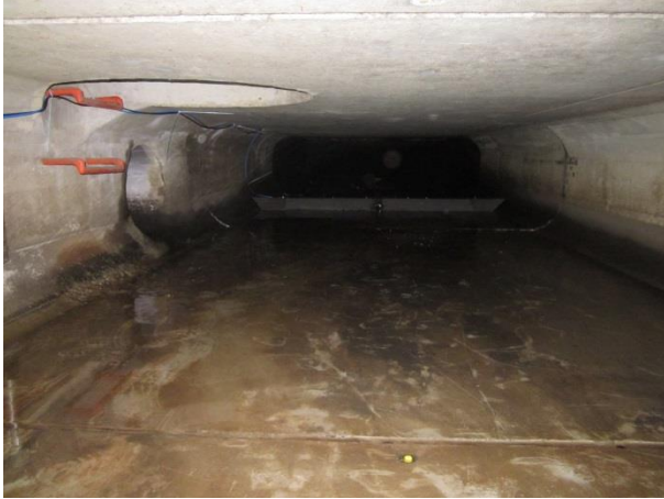
Abb. 11: Spectrolyser im Ablauf hinter der Drossel (siehe Rohröffnung linke Seite)
