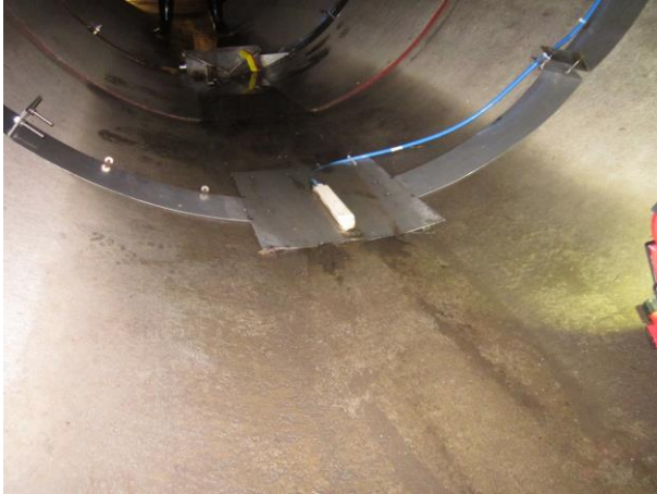
Abb. 13: Volumenstrommessung im Zulauf
