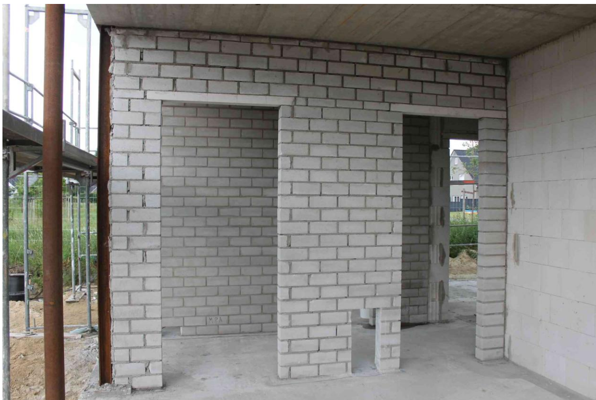
Anhang 5.18: Fertiggestelltes Mauerwerk, Ansicht aus dem Büroraum
