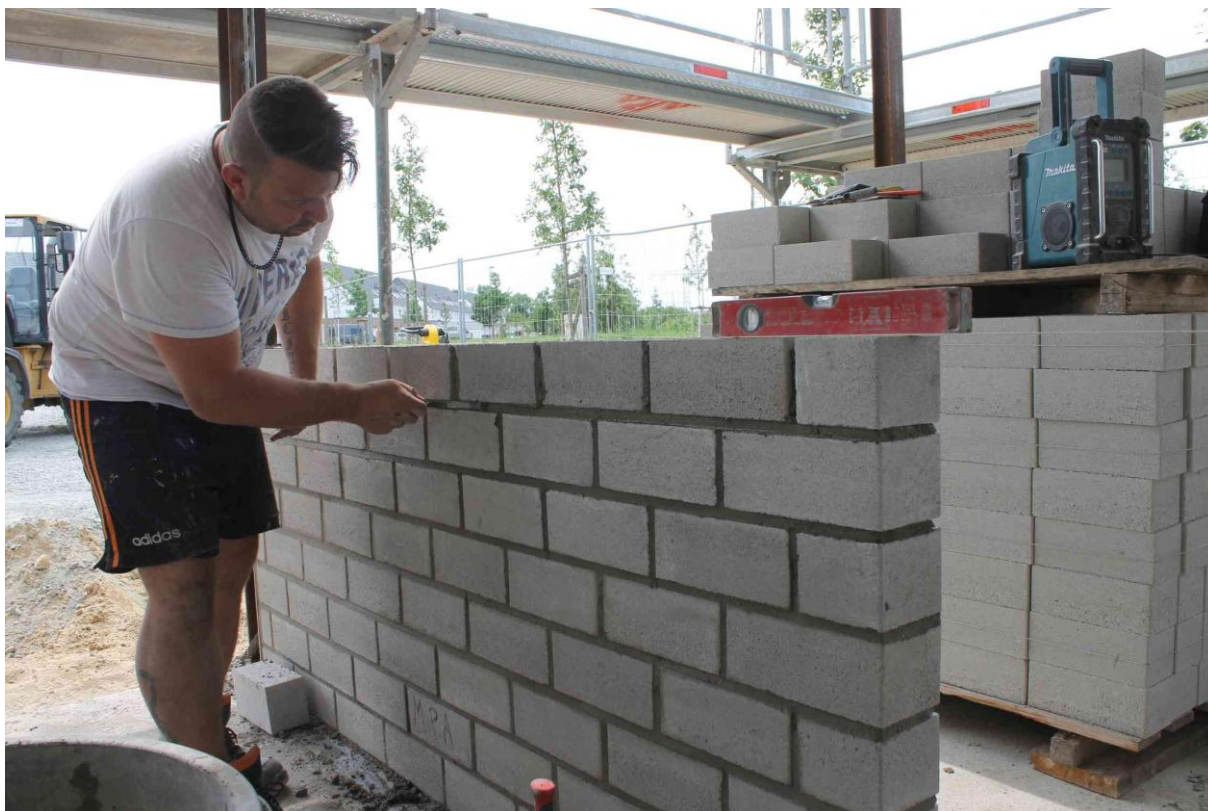
Anhang 5.10: Glätten der Lagerfuge des Sichtmauerwerks
