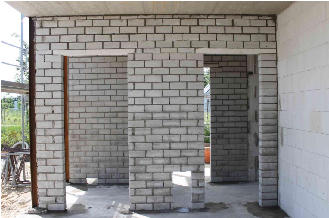
Abb. 7: Wände aus Porenbeton-Recyclingprodukten, Ansicht vom Büroraum
