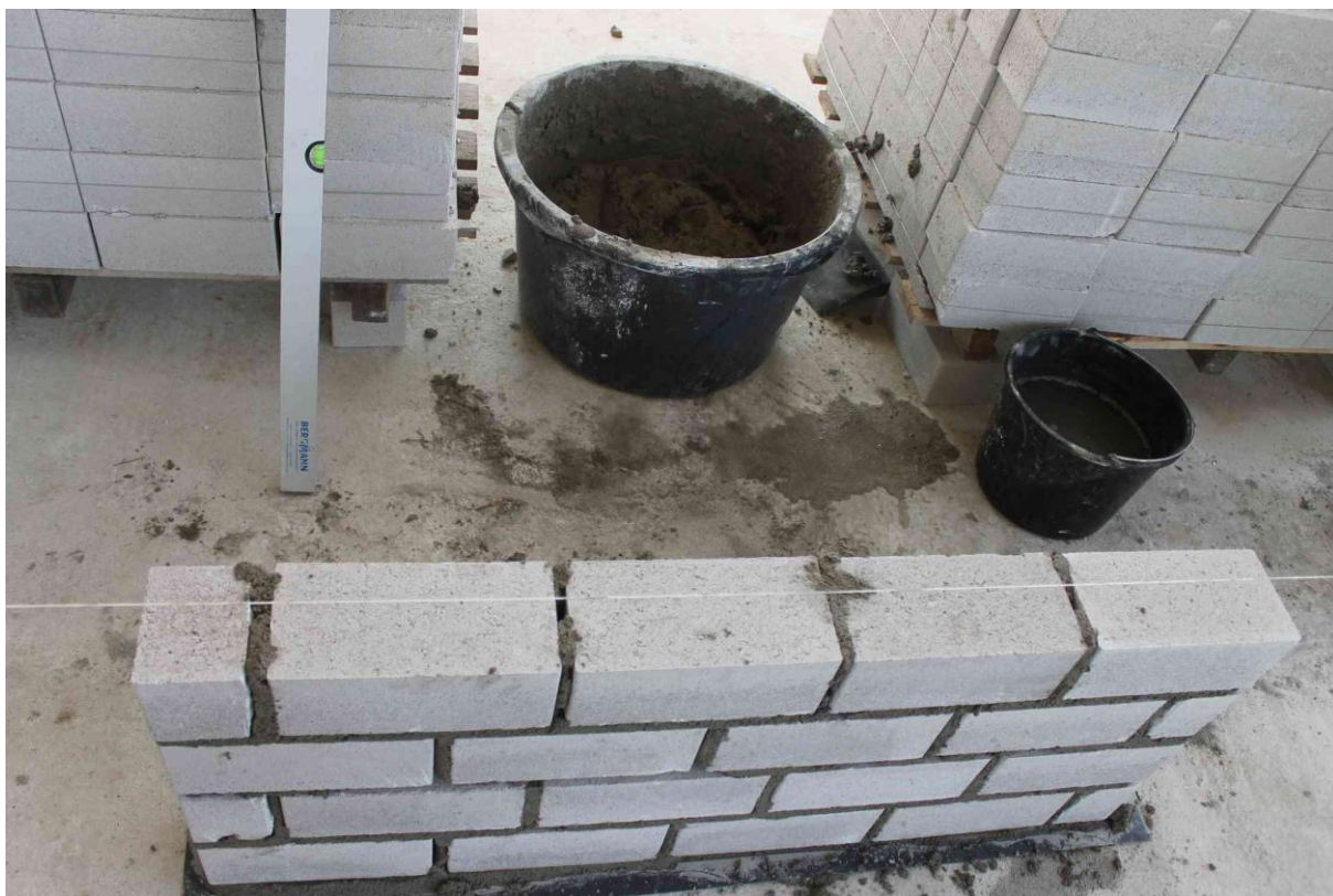
Anhang 5.5: Sicht auf die Stoßfugen
