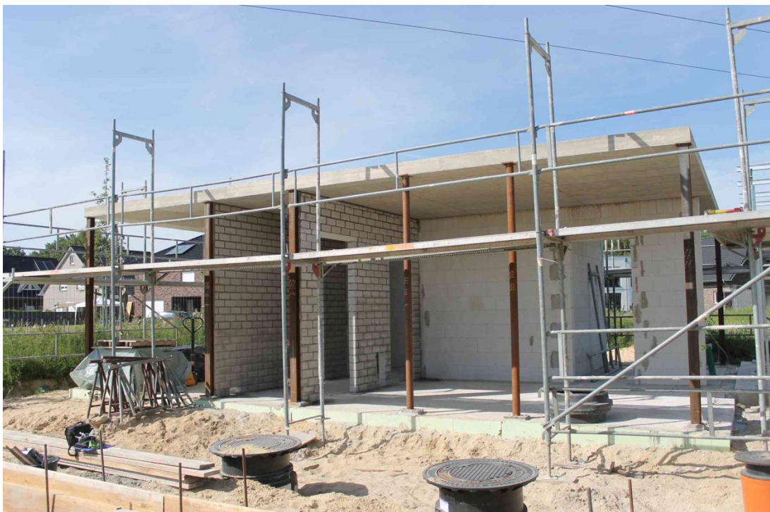
Abb. 6: Wände aus Porenbeton-Recyclingprodukten, Übersicht
