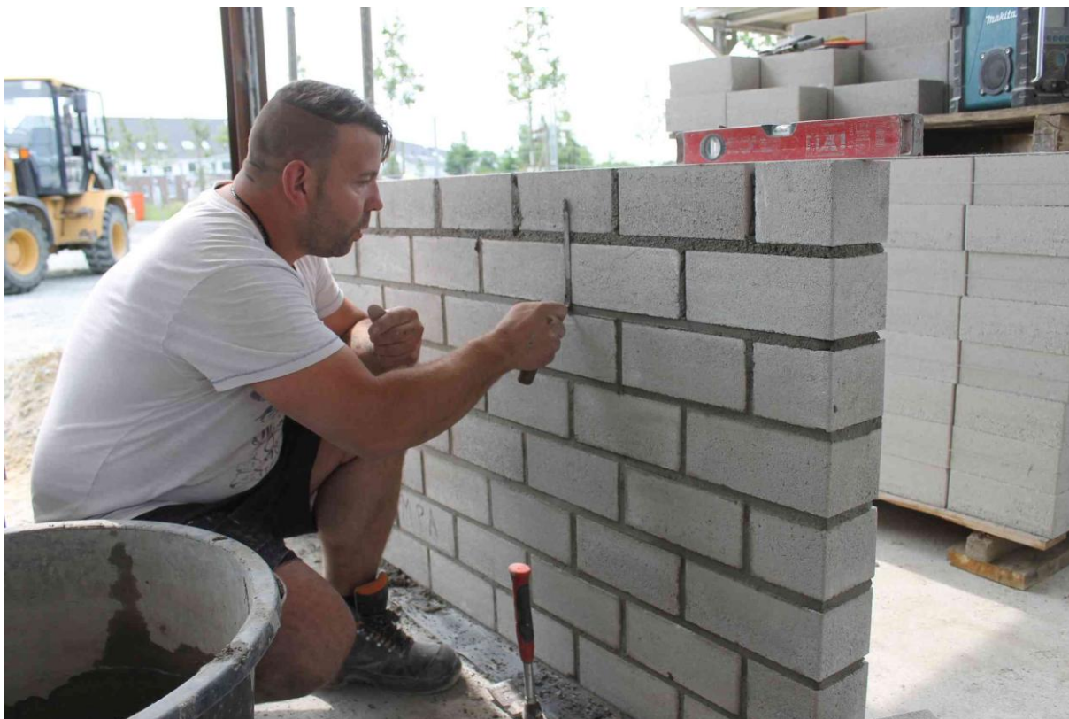
Anhang 5.9: Glätten der Stoßfuge des Sichtmauerwerks
