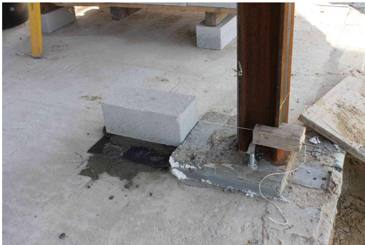
Anhang 5.4: Ausrichten der ersten Steinlage mittels Richtschnur
