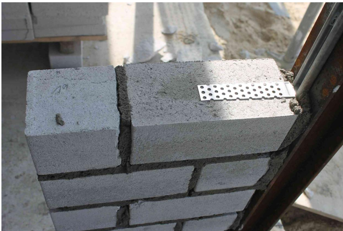
Anhang 5.7: Sicherung der Mauer an angrenzender Stahlstütze
