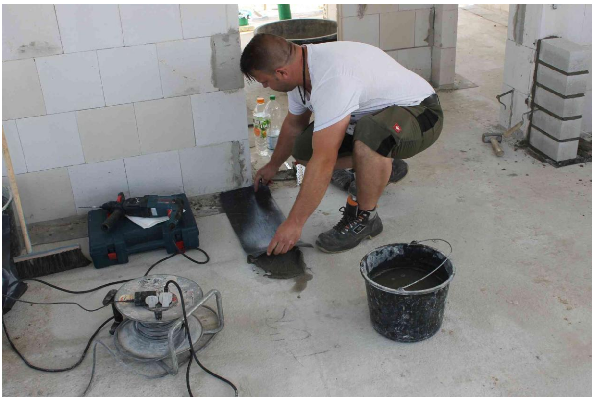
Anhang 5.2: Anbringen der Abdichtung gegen aufsteigende Feuchtigkeit
