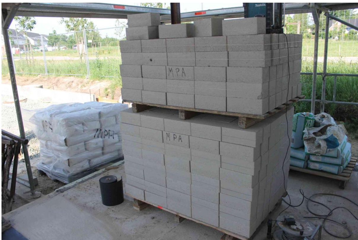
Anhang 5.1: Porenbeton-Recyclingprodukte auf der Baustelle
