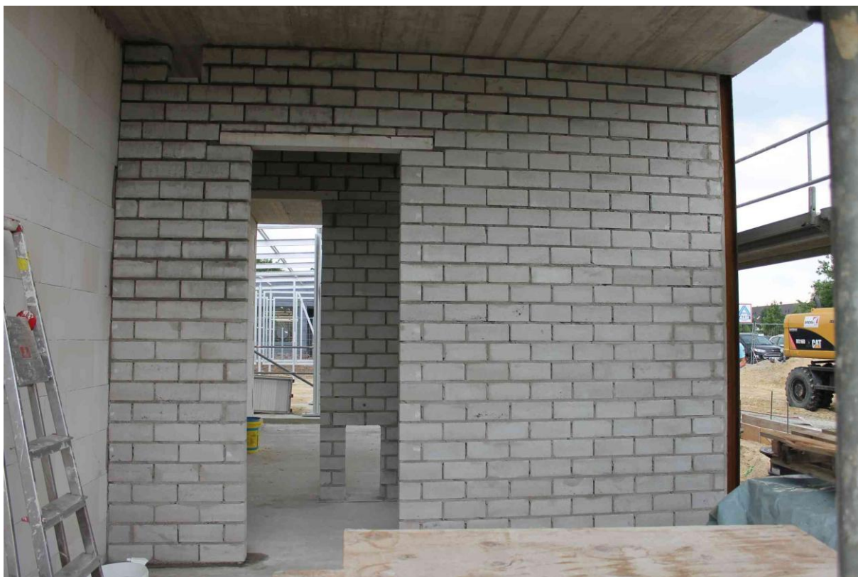
Anhang 5.17: Fertiggestelltes Mauerwerk, Ansicht aus dem Sozialraum
