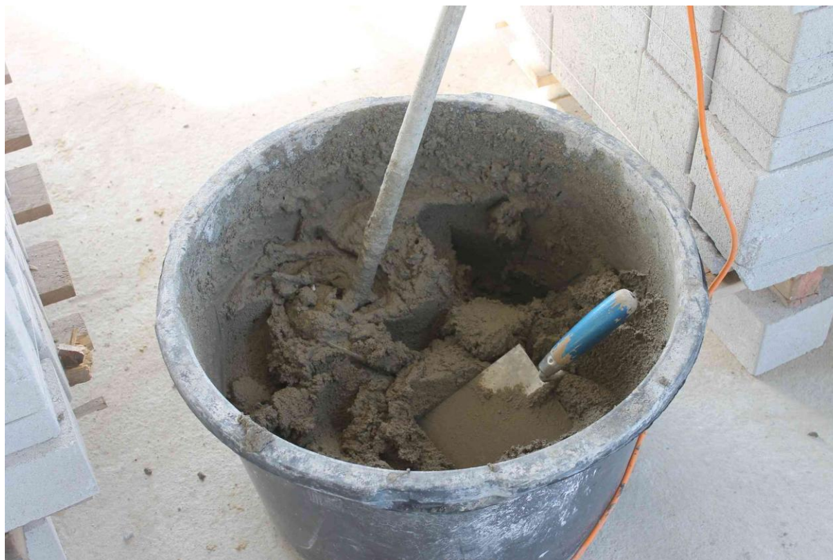
Anhang 5.3: Auf der Baustelle gemischter Frischmörtel
