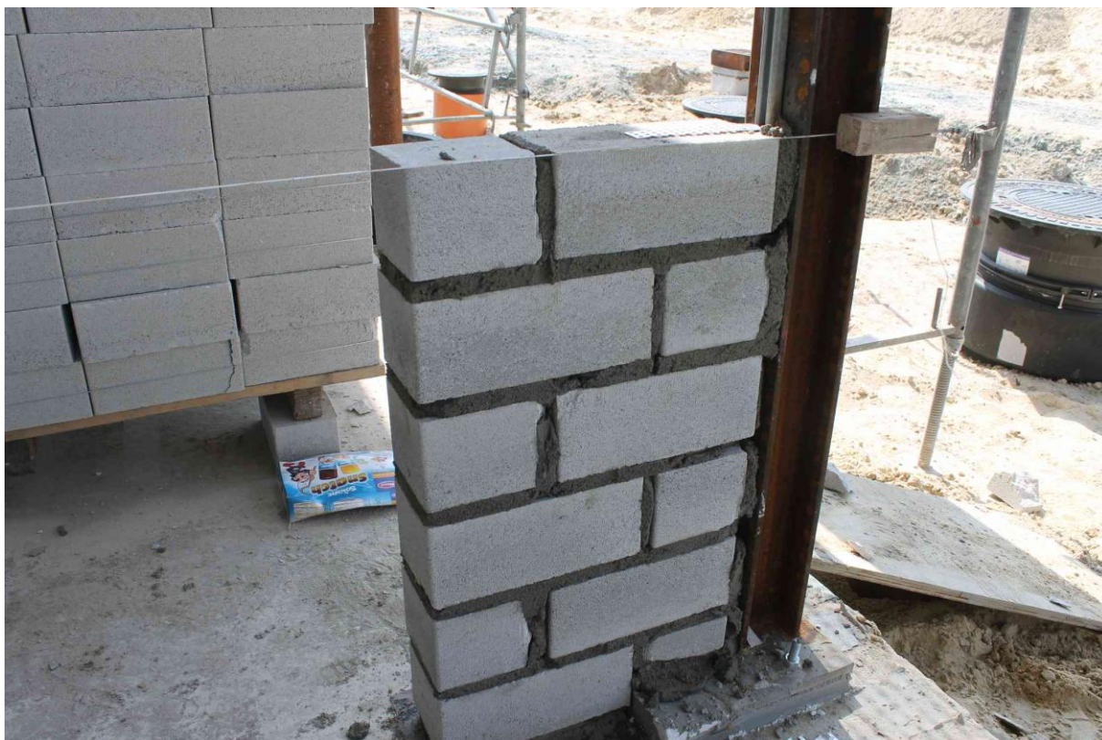
Anhang 5.6: Mauerteilstück, mit dem Hammer gespaltene Steine verarbeitet
