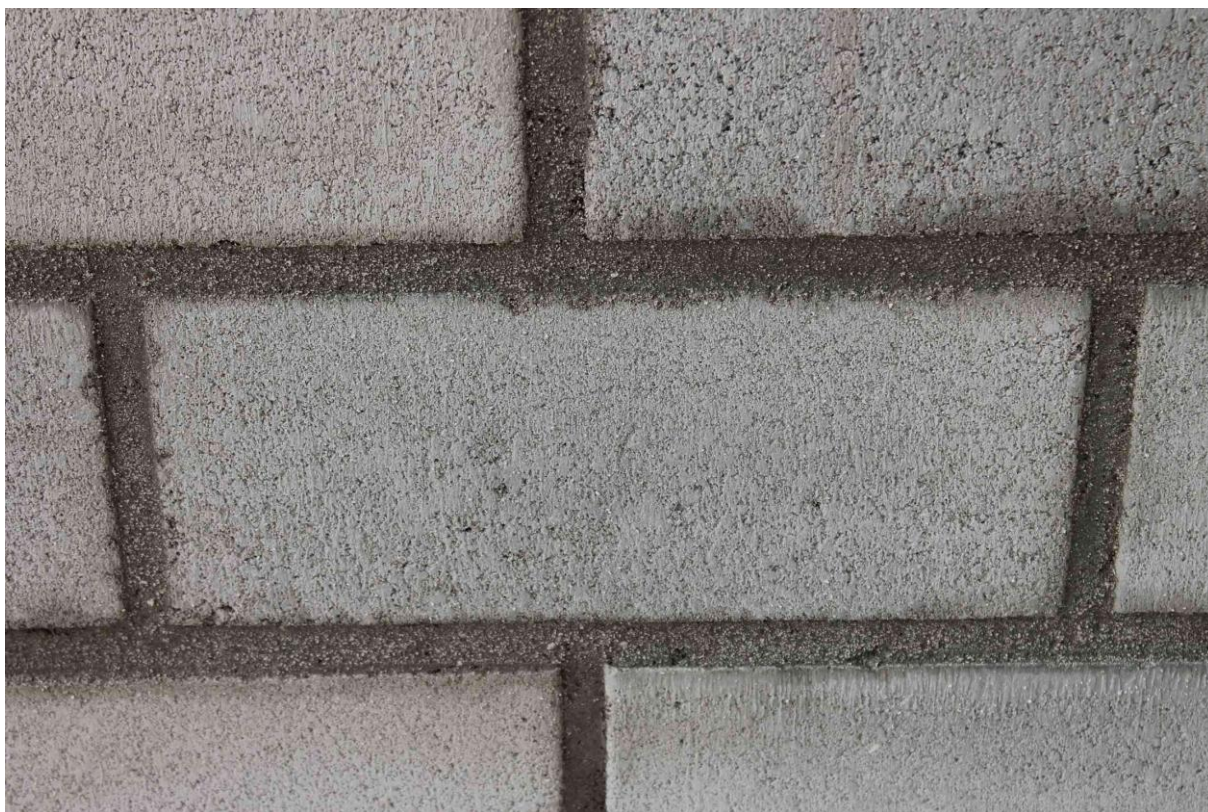
Anhang 5.13: Geglättete Fugen des Sichtmauerwerks, Nahaufnahme
