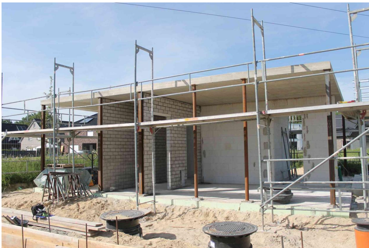
Anhang 5.15: Rohbau mit fertiggestelltem Mauerwerk aus PB-RC-Produkten
