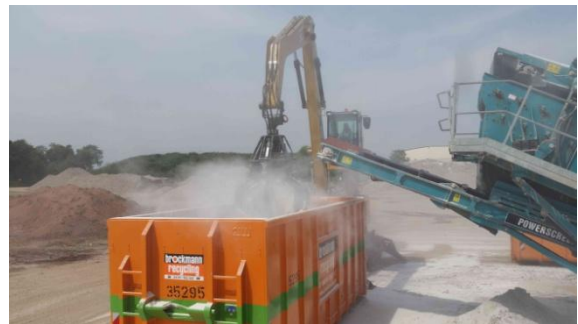
Anhang 1.4: Homogenisierung im Auffangcontainer
