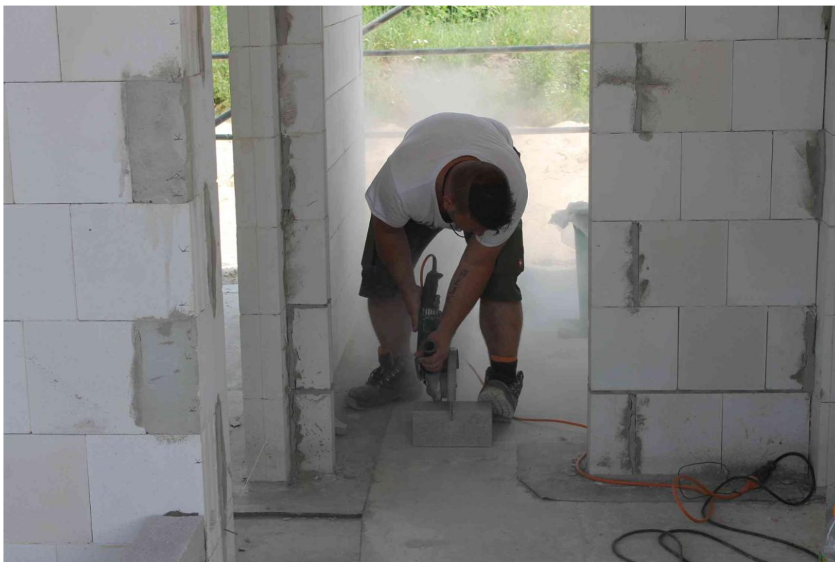
Anhang 5.8: Sägen eines Recyclingsteines mittels Winkelschleifer mit Trennscheibe
