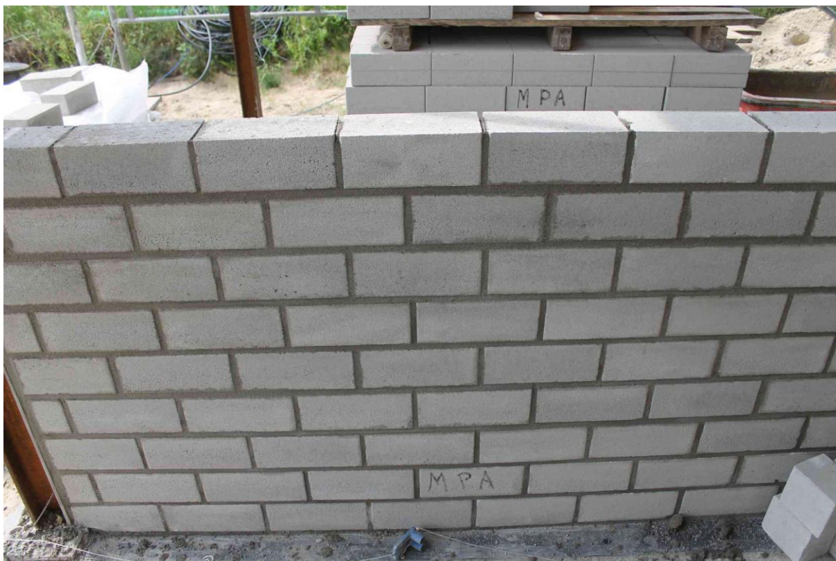
Anhang 5.12: Geglättete Fugen des Sichtmauerwerks
