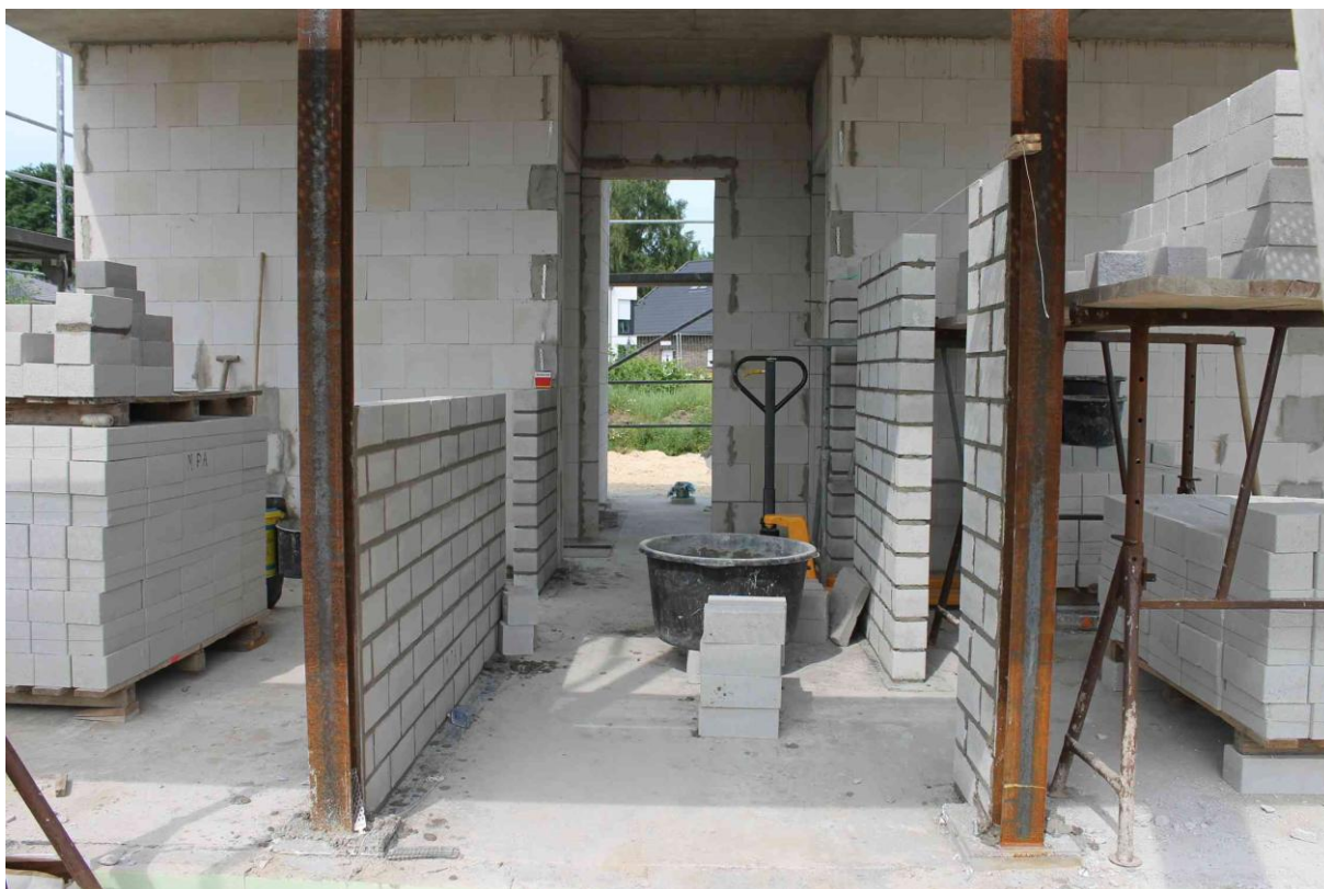
Anhang 5.14: Am Ende des ersten Arbeitstages errichtetes Mauerwerk
