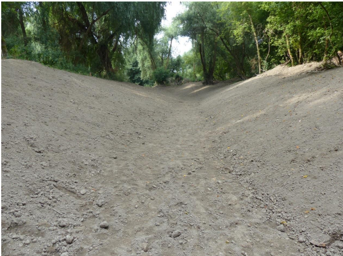
Abbildung 4: Neu angelegter Graben zur Anbindung des Schlauchgrabens an die Hagbauschlut
