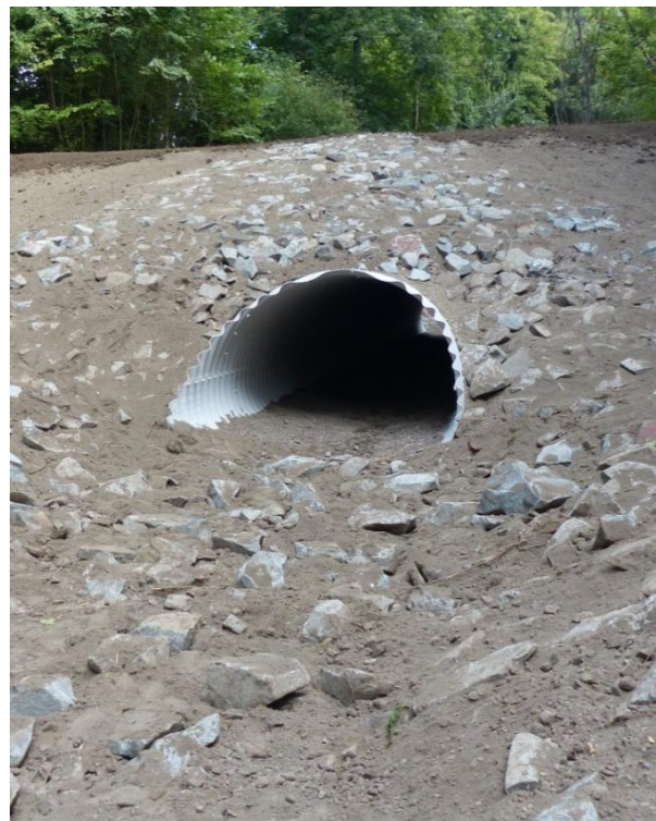
Abbildung 2: Vergrößerter Durchlass nach der Maßnahme
