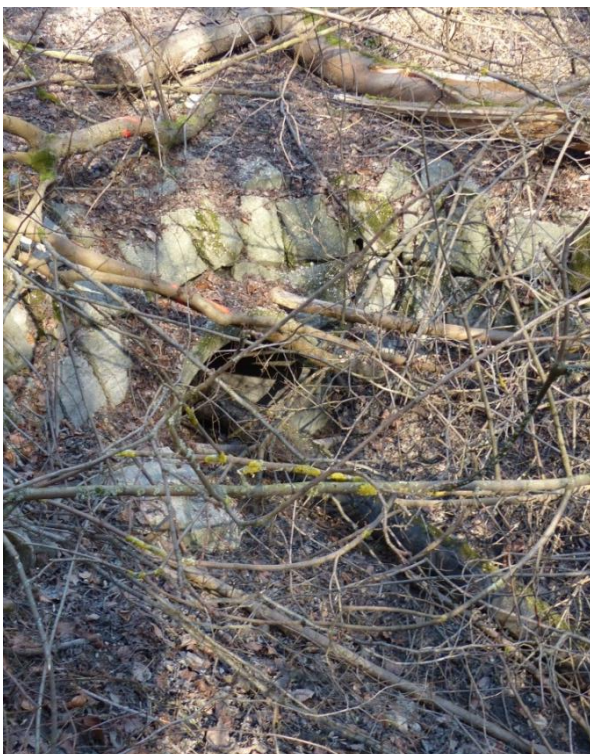
Abbildung 1: Durchlass vor der Maßnahme
